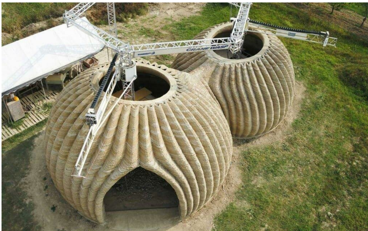
Obrázek 11: Klenutá budova vytvořená procesem 3D tisku [16]
