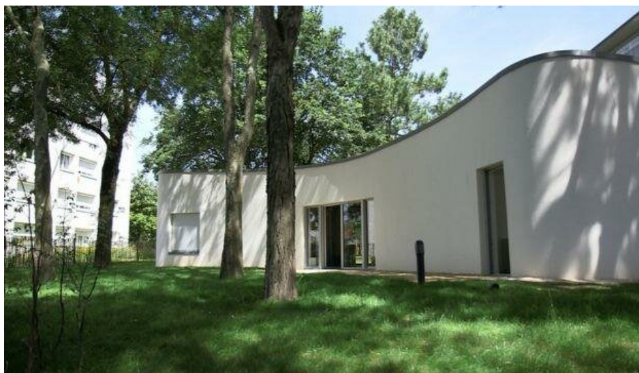
Obrázek 6: Rodinný dům v Nantes vyrobený 3D tiskem [12]
