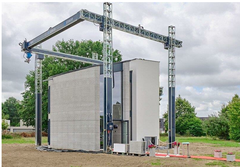
Obrázek 9: Portálový jeřáb schopný zajistit tisk vícepatrové budovy [15]
