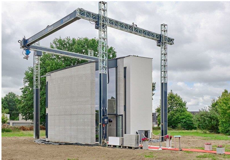
Obrázek 9: Portálový jeřáb schopný zajistit tisk vícepatrové budovy [15]
