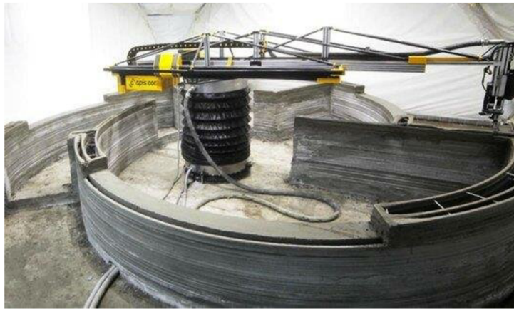
Obrázek 5: Stavba domu 3D tiskem s použitím pevného robotického ramena [11]
