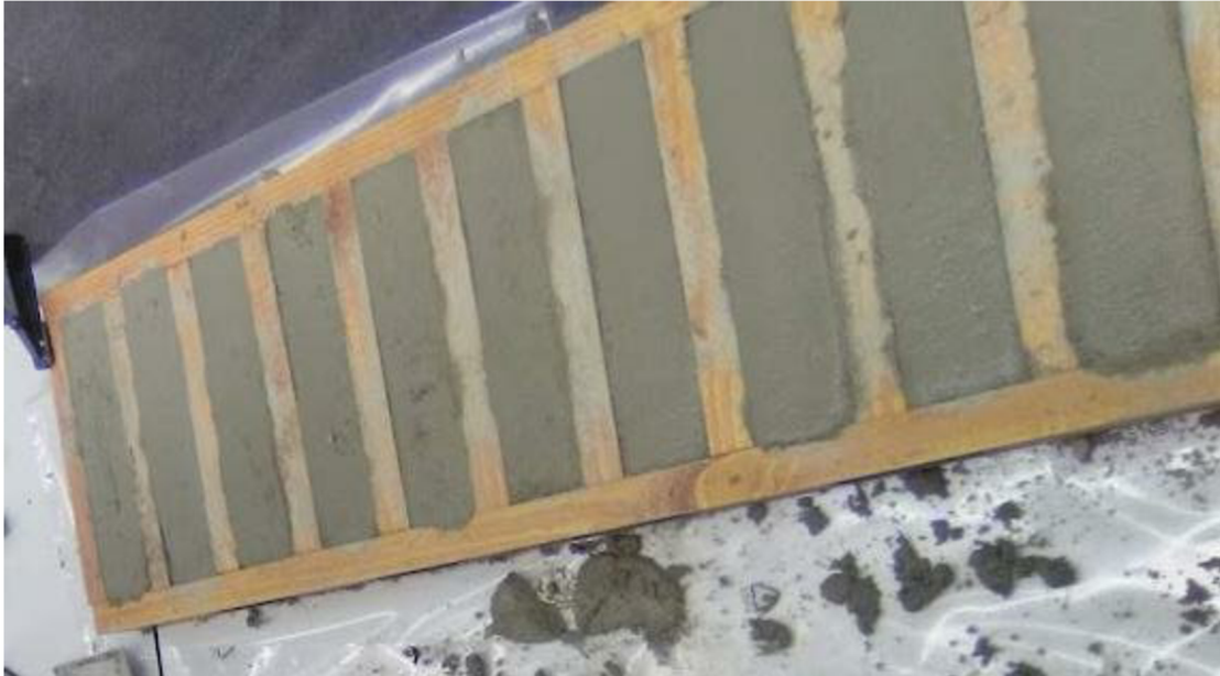
Obrázek 19: Obrázek formy bednění
