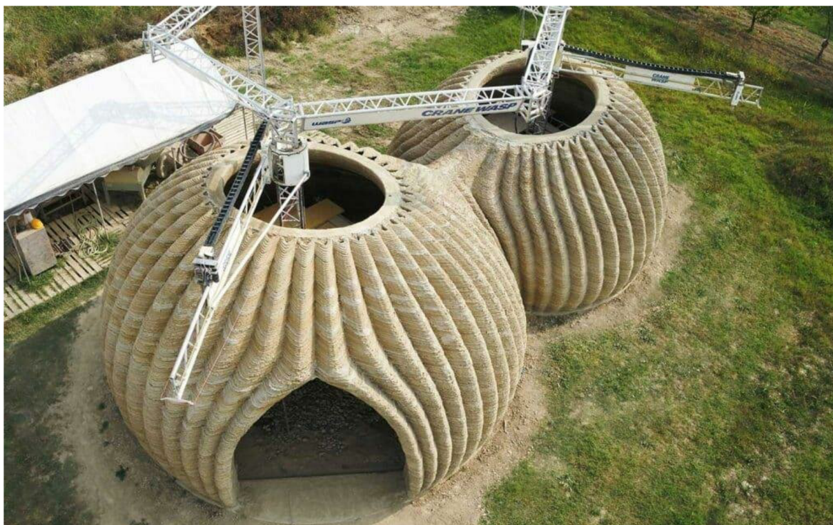
Obrázek 11: Klenutá budova vytvořená procesem 3D tisku [16]
