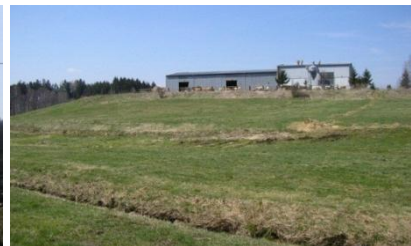
foto. č. 29: Zemědělská stavba „Nová Farma“ - jižní pohled (Všetečková, březen 2010).
