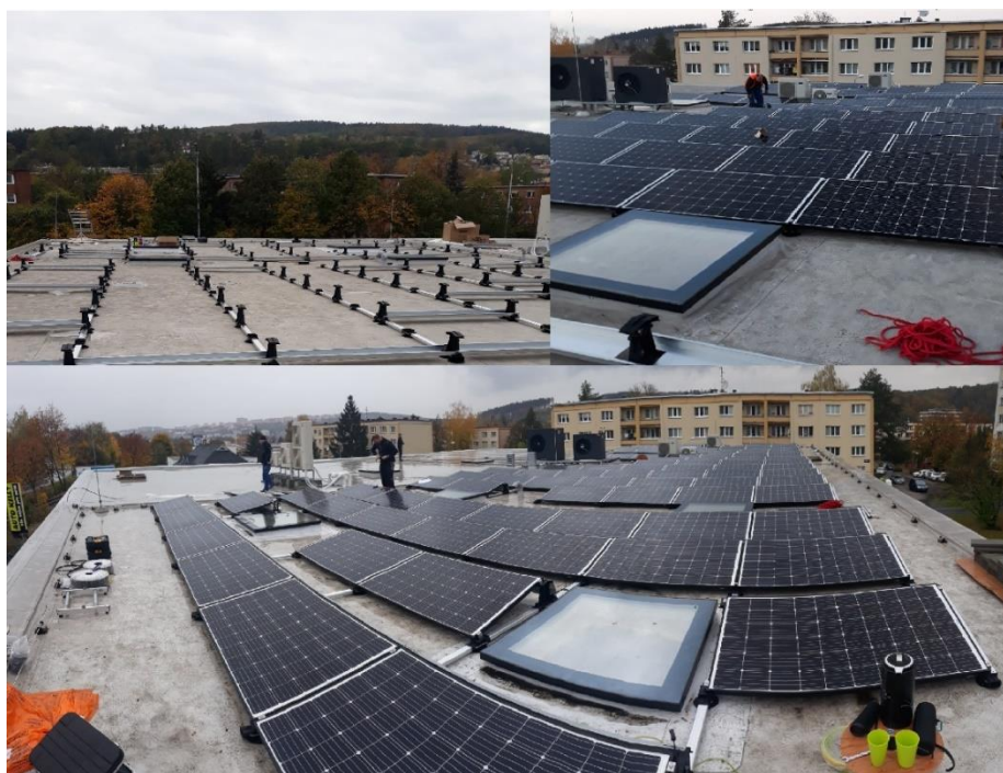
Obr. 5-4 Průběh instalace FVE
