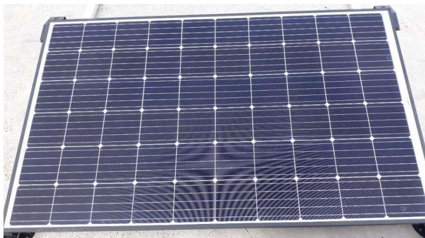
Obr. 5-10 Krytí FVE před klimatickými podmínkami
