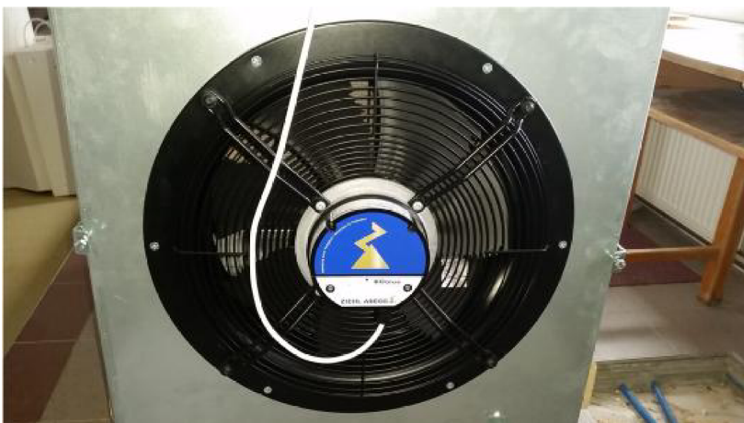
Obr. 3.5 Axiální ventilátor
