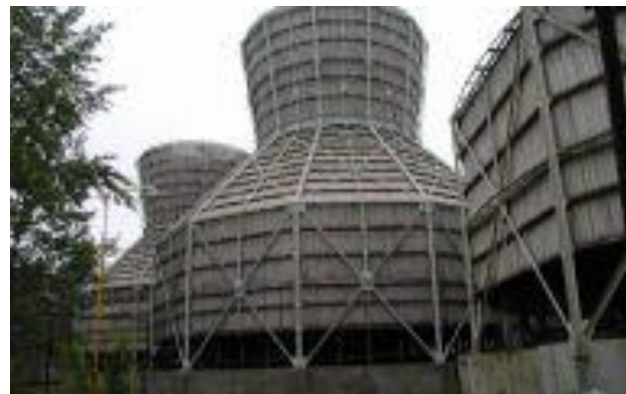
Obr. 2.2: Dřevěné věže [c]
