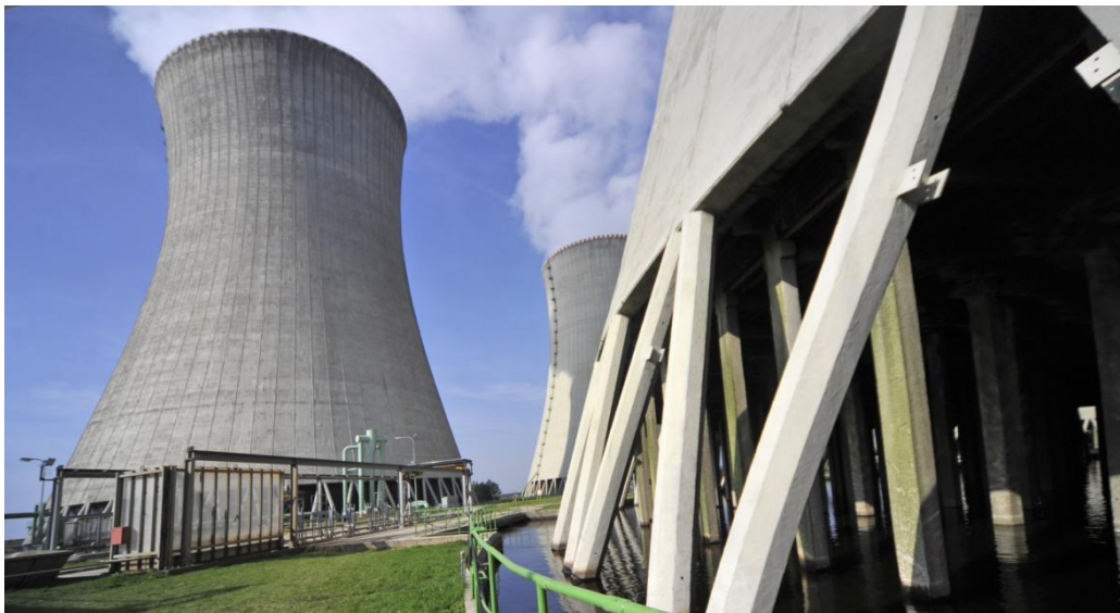
Obr. 5: Věž Jaderné elektrárny v Dukovanech [a]
