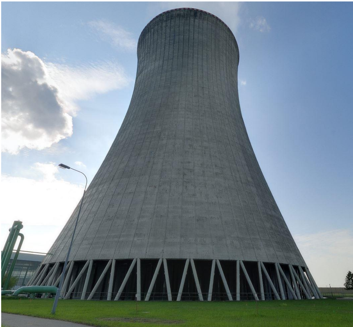
Obr. 1: Jaderná elektrárna Dukovany – Věž typu ITTERSON [a]
