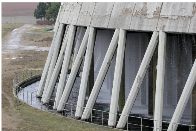
Obr. 5.2.1: Šikmé vnější sloupy [c]
