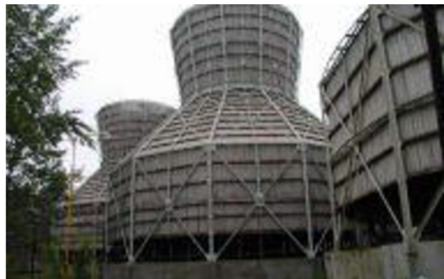
Obr. 2.2: Dřevěné věže [c]
