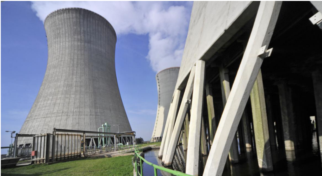
Obr. 5: Věž Jaderné elektrárny v Dukovanech [a]
