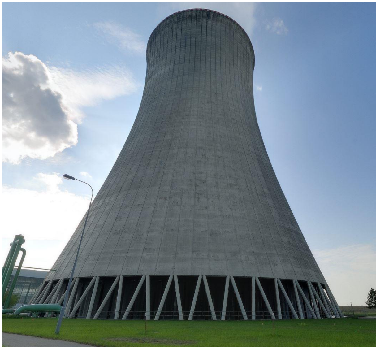
Obr. 1: Jaderná elektrárna Dukovany – Věž typu ITTERSON [a]
