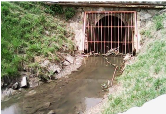
Obr. 15: Zatrubnění Prostřednička (autor, 2015)
