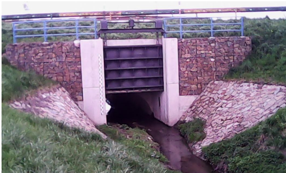
Obr. 18: Hradicí objekt u čistírny odpadních vod (autor, 2015)
