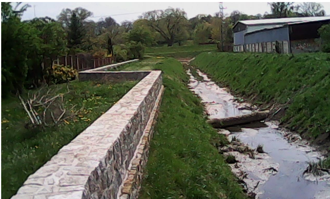
Obr. 17: Zemní hráze a ochranná kamenná zídka (autor, 2015)
