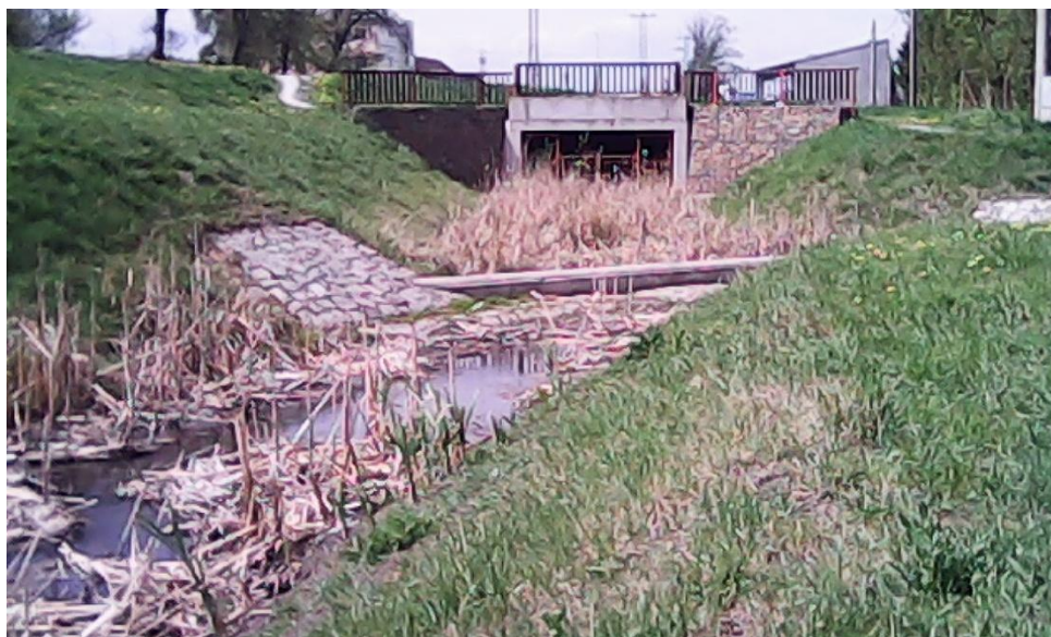
Obr. 10: Zatrubnění obtoku s nátokem a prahem do vodního toku Prostředníček (autor, 2015)
