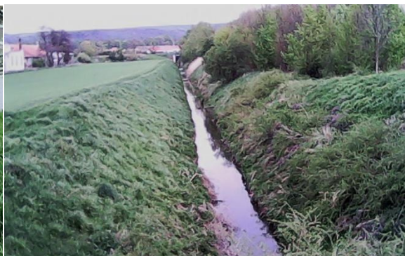
Obr. 12: Prostředníček po silnici I/50 (autor, 2015)
