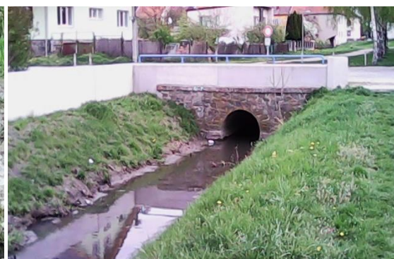
Obr. 14: Výustění ze zatrubnění Prostředníčka (autor, 2015)
