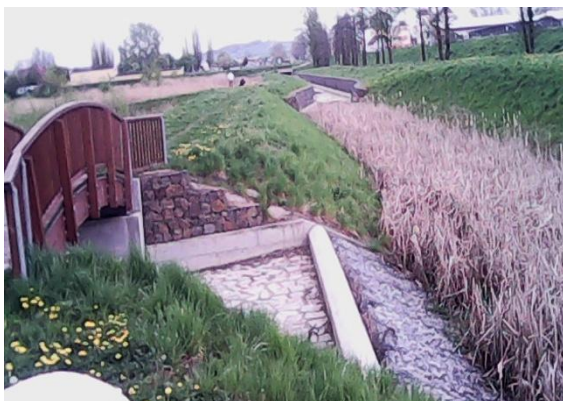
Obr. 8: Lávka s přelivným objektem (autor, 2015)
