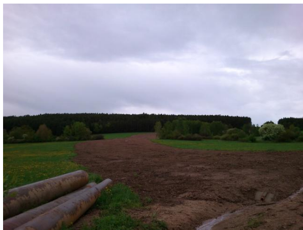
Obr. 6 Výstavba plynovodu (Březina), foto: Sejpková
