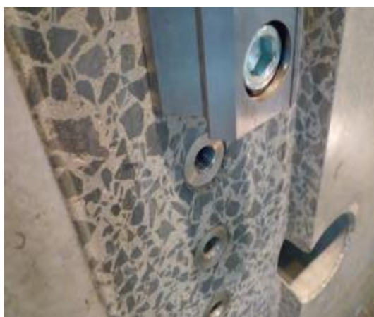
Obrázek 10: Detail broušené plochy a vlepěných závitových pouzder pro lineární vedení [21]
