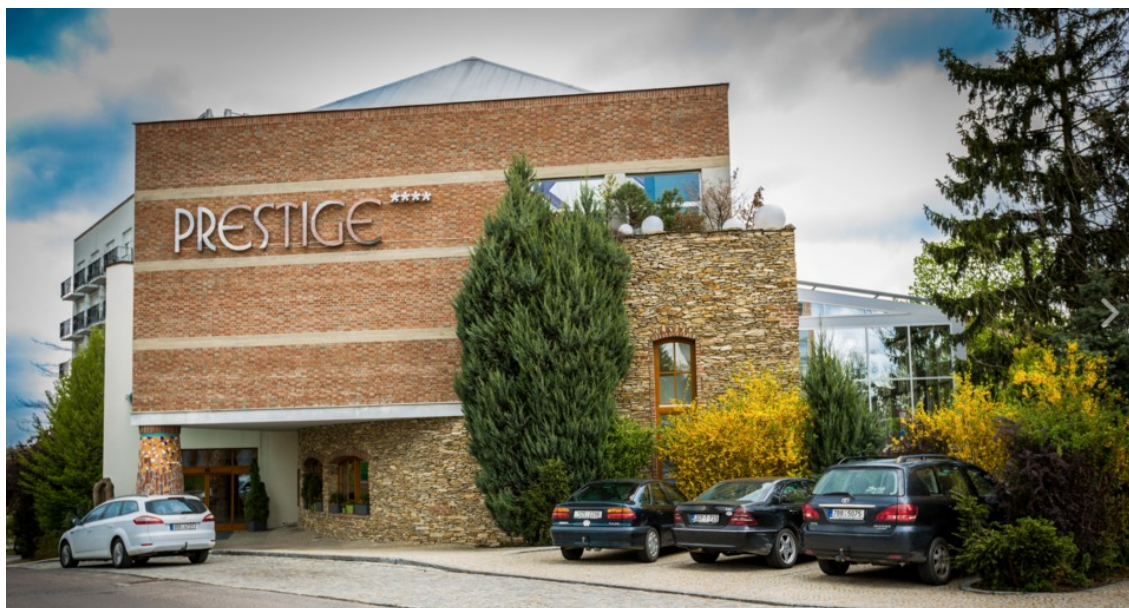
Obrázek 3: Exteriér Hotelu Prestige**** (Zdroj: 16)
