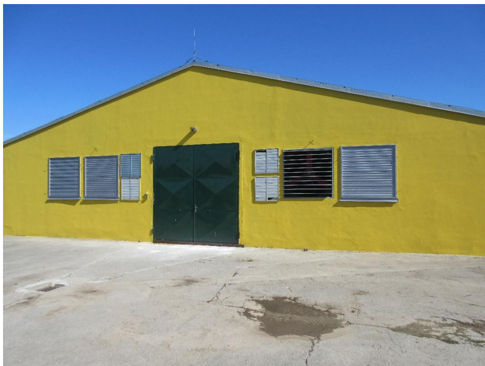
Obrázek 23 – Výkrmová hala se štítovými ventilátory (zdroj: Ing. Radim Kuneš)
