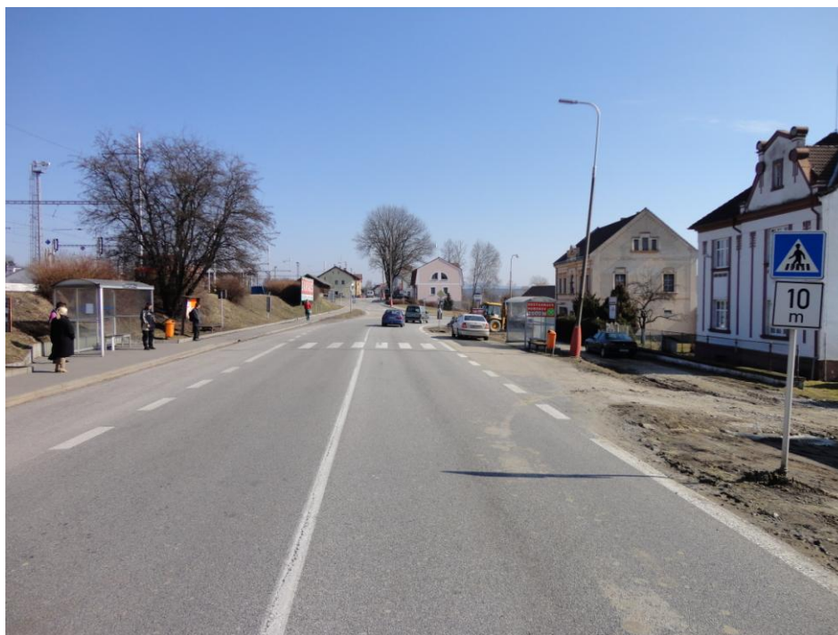
Obrázek č. 16: Příklad nesprávně umístěného VDZ č. V7 na sil. č. I/3 v intravilánu obce Kaplice-nádraží. Zdroj dat: Policie ČR
