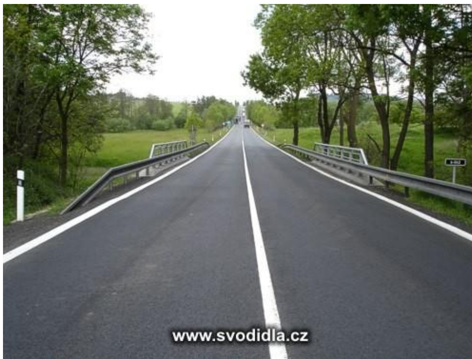
Obrázek č. 17: Příklad užití zábradelního svodidla na mostním objektu.
