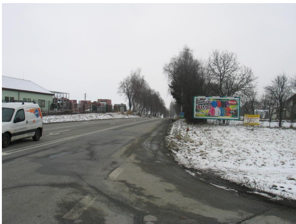
Obrázek č. 27: Příklad nevyhovujícího rozhledu v křižovatce sil. č. I/3 se sil. č. III/15610 v k.ú. Velešín. Zdroj dat: Policie ČR
