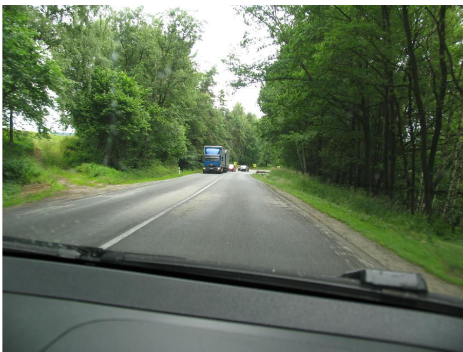
Obrázek č. 15: Příklad nečitelného VDZ č. V4 na sil. č. I/3 v k.ú. Netřebice.
