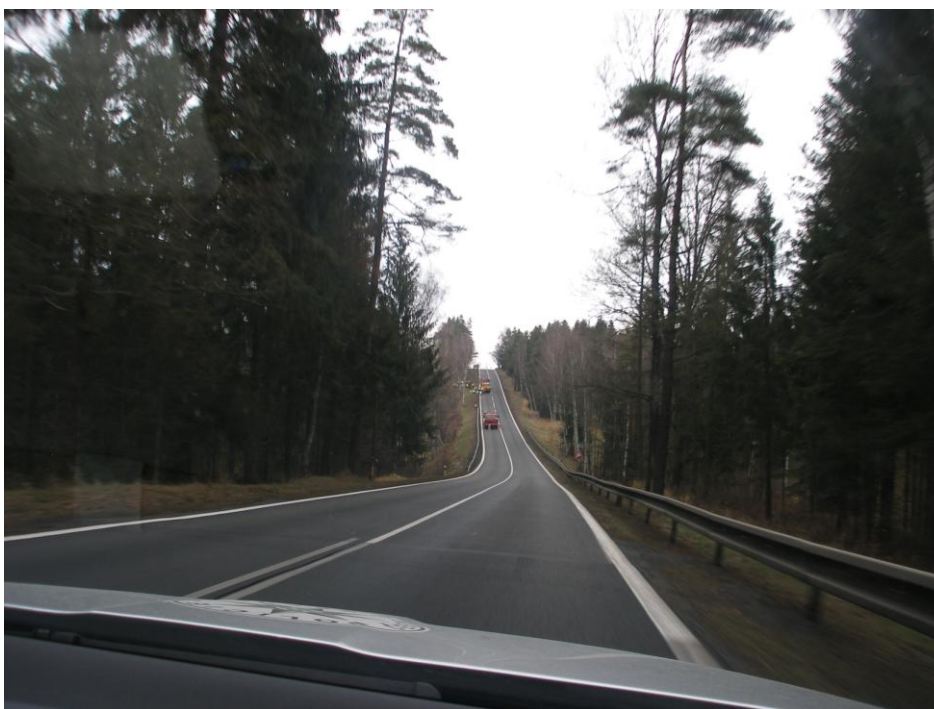
Obrázek č. 22: Příklad nevhodného šířkového uspořádání sil. č. I/3 v k.ú. Dolní Dvořiště. Zdroj dat: Policie ČR
