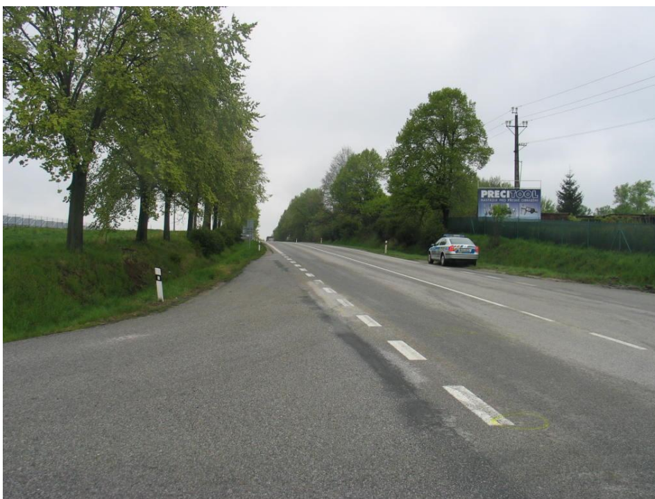
Obrázek č. 26: Příklad nevyhovujícího rozhledu v křižovatce sil. č. I/3 se sil. č. III/15710 v k.ú. Velešín. Zdroj dat: Policie ČR
