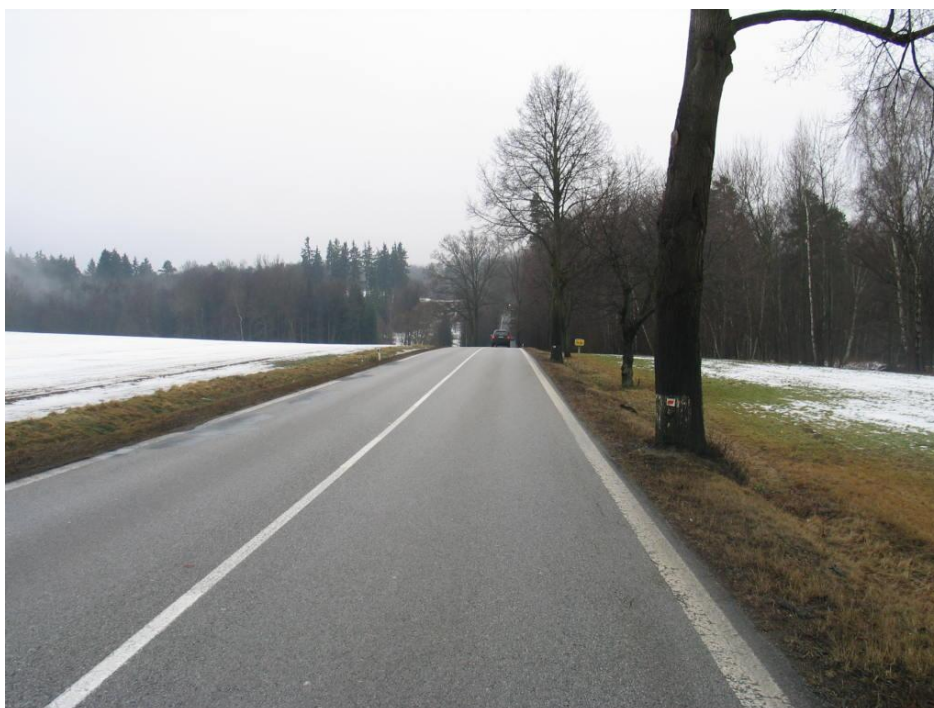
Obrázek č. 23: Příklad nevhodného výškového vedení sil. č. I/3.
