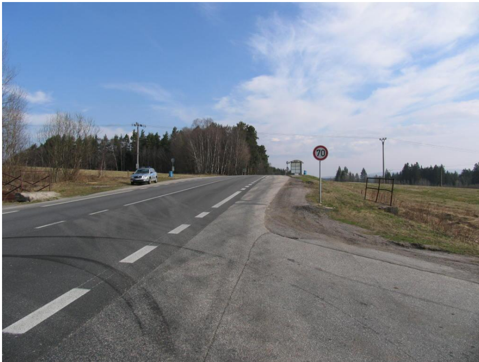
Obrázek č. 28: Příklad nevyhovujícího rozhledu v křižovatce sil. č. I/3 se sil. č. III/00363 v k.ú. Suchdol. Zdroj dat: Policie ČR
