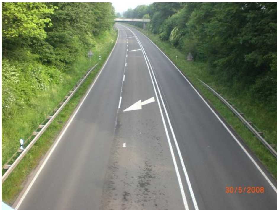
Obrázek č. 25: Příklad uspořádání 2+1 z Německa. Zdroj dat: www.czrso.cz
