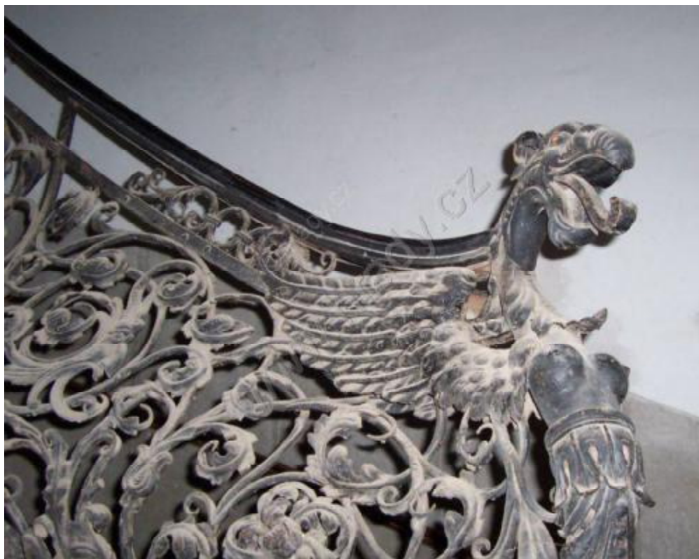
11. Prostějov, zámek, 2006, dekorativní kované schodišťové zábradlí. Foto: Ivo Rozehnal. Zdroj: http://www.hrady.cz/?OID=1178&PARAM=2 , vyhledáno 18. 4. 2014
