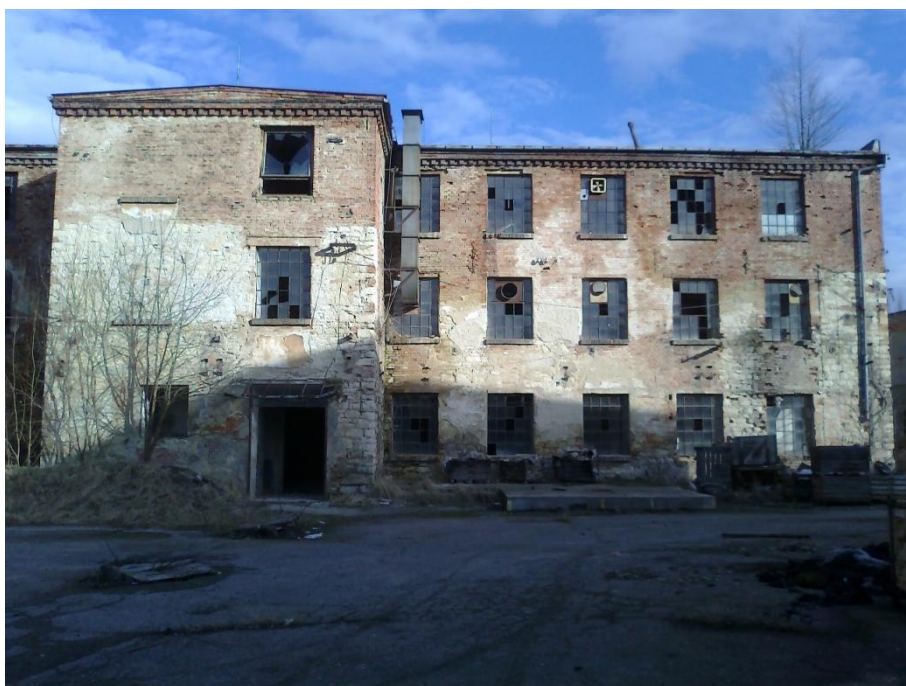
Posukovaná přádelna, původní budova „Schindlerovy továrny“
