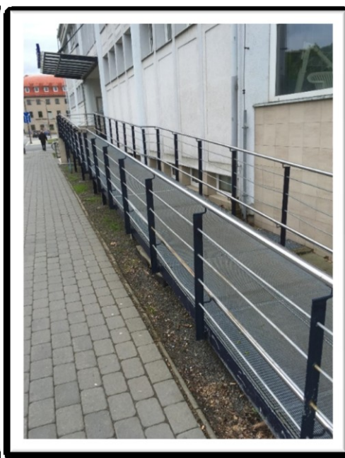
Obrázek č. 2 Rampa u hlavního vstupu
