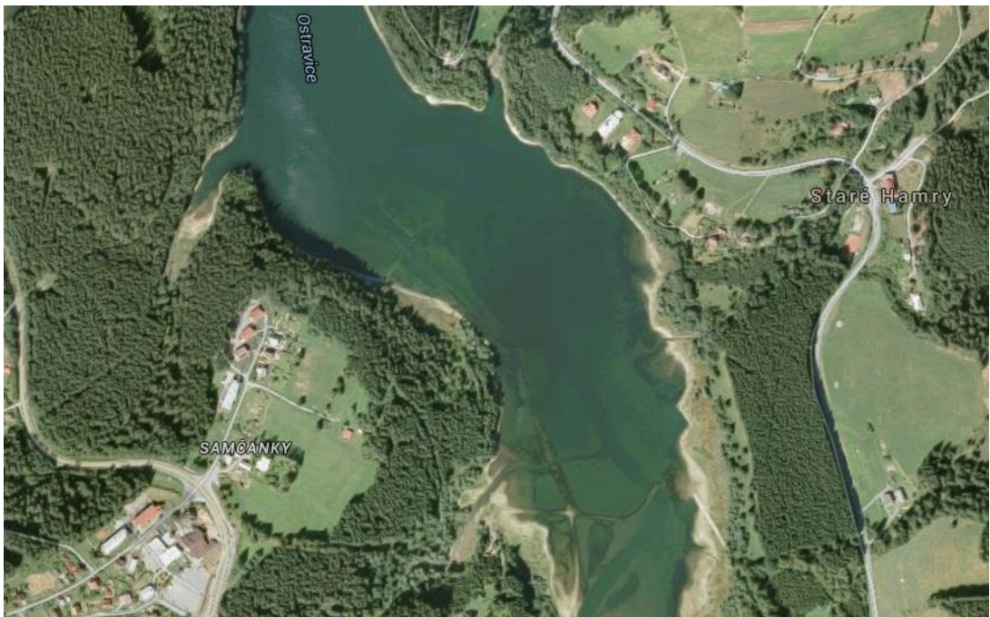
Obr. 4 a Obr. 5 . Zachycují stejný pohled na n kdejší centrum obce. První snímek pochází z roku 1953 ( http://www.cenia.cz ). Na spodním snímku na levé stran je nové centrum obce sSam anky%ona pravé stran část p vodní obce. V horní části fotografie, v blízkosti nádr0e je dochovaný kostel. ( http://googlemaps.cz )
