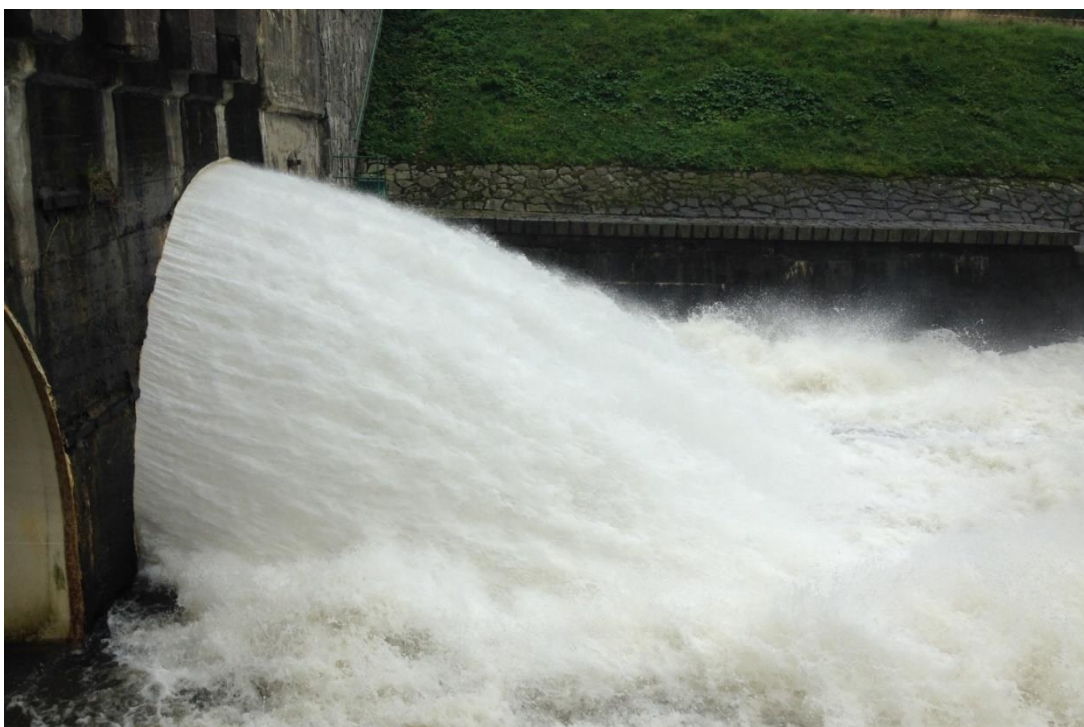
Obr. 14 . Spodní výpusti, vývar (foto autor, 3. 10. 2014)
