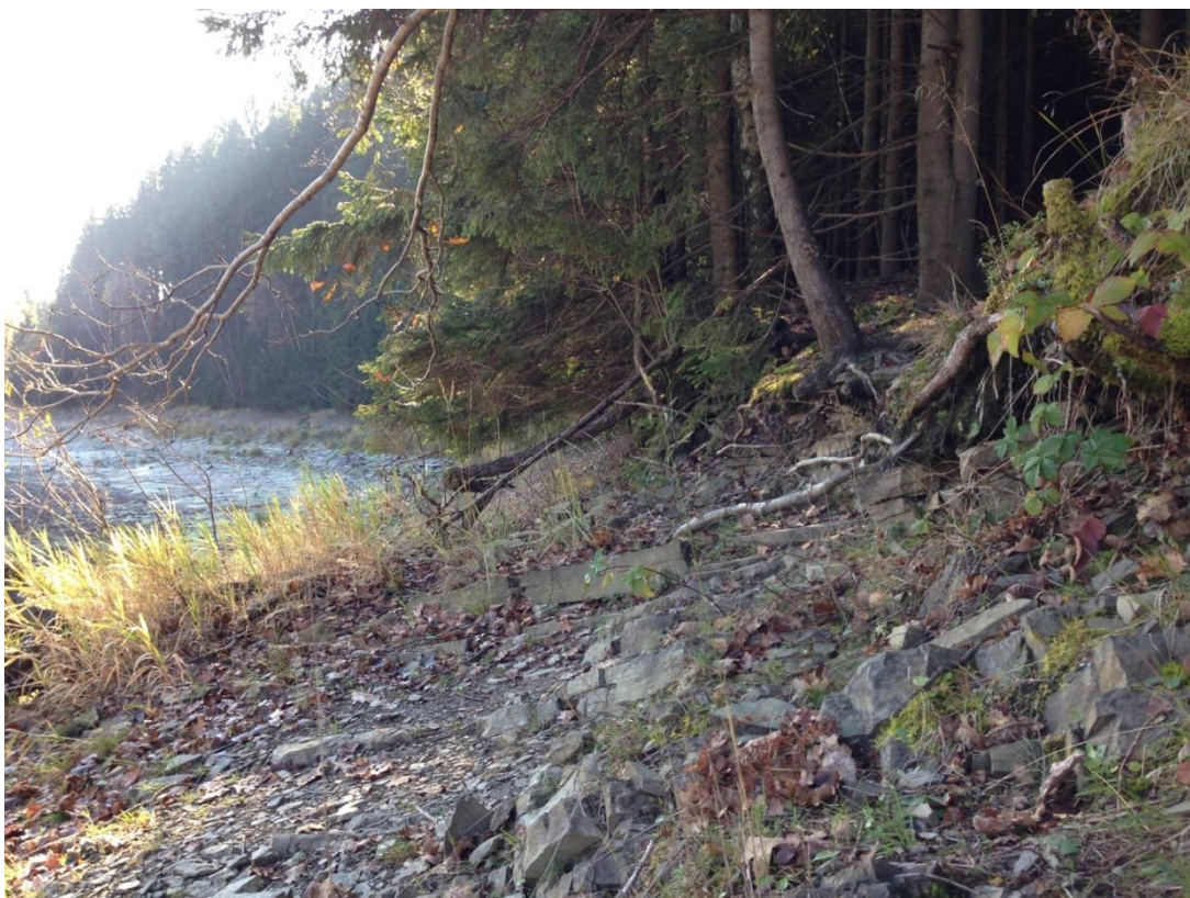
Obr. 15 . B ehová abraze . do této úrovn ě terénu b On sahá voda (foto autor, 12. 1. 2015)
