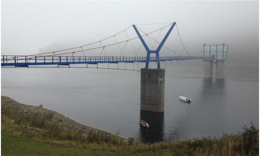
Obr. 10 . P ístupová lávka, odb rný objekt (foto autor, 3. 10. 2014)
