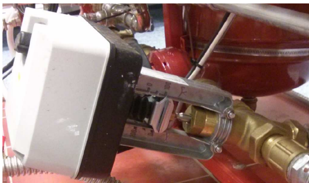
Obrázek 43 Lineární pohon Honeywell
