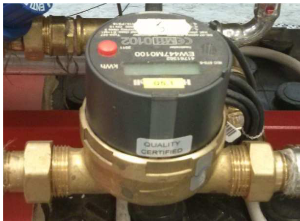
Obrázek 45 Měřič tepla Honeywell
