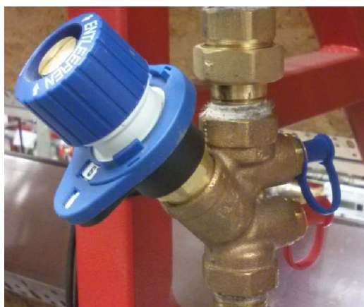
Obrázek 46 Vyvažovací ventil Honeywell
