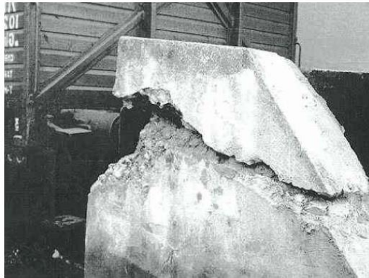
Obr. 5.2 Porušené betonové zarážedlo [1]
