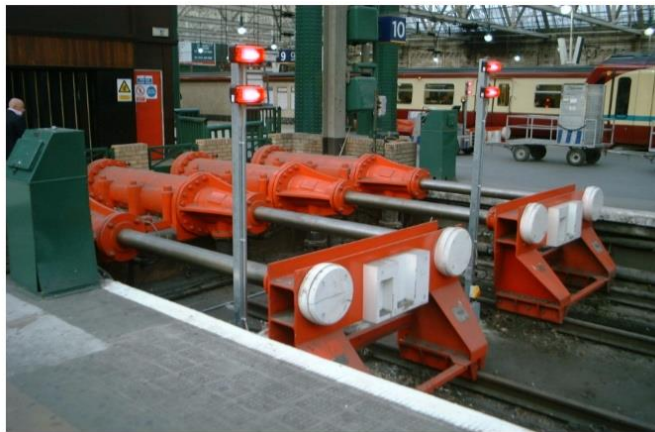
Obr. 5.3 Pevné zarážedlo s hydraulickými nárazníky [12]
