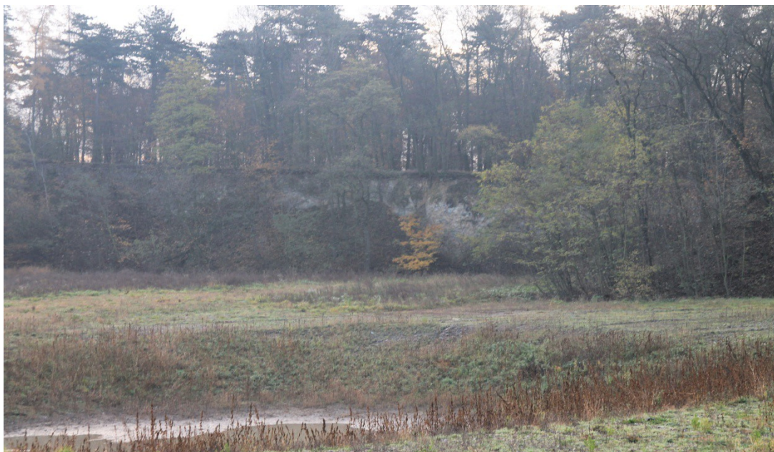
Obr. 13: Lom bývalé cementárny v Grygově, jižní stěna z 13. 11. 2014
