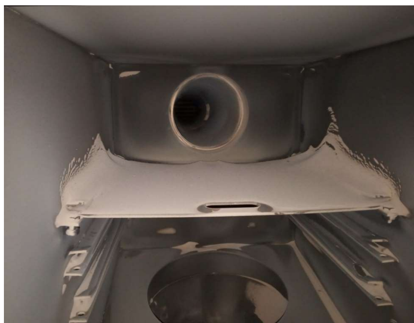
Obr. 9: Pohled dovnitř usazovací komory po ukončení spalovací zkoušky.
