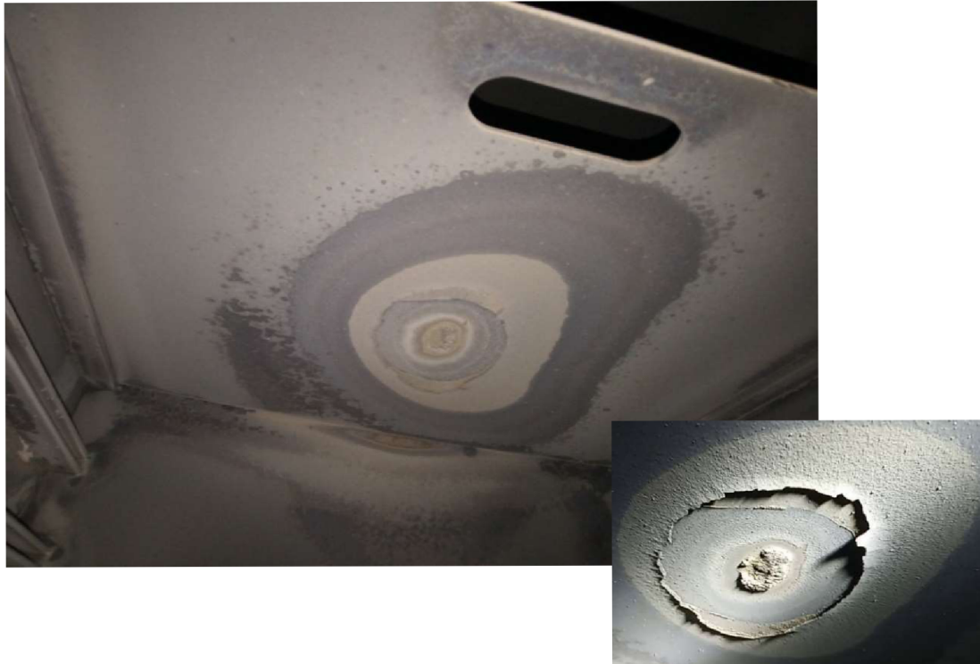
Obr. 21: Nános na spodní straně přepážky v usazovací komoře.
