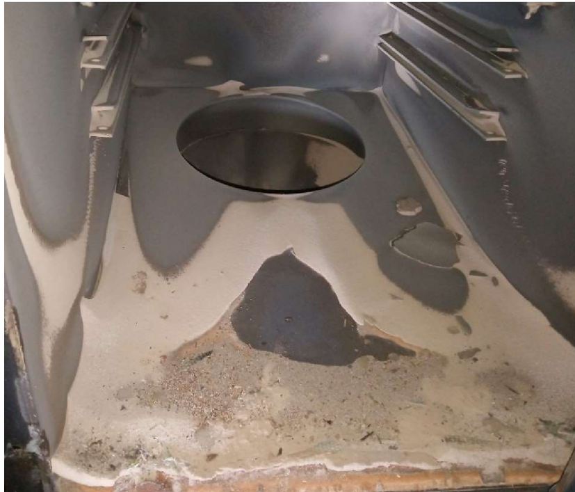
Obr. 19: Sypký nános na dně usazovací komory.
