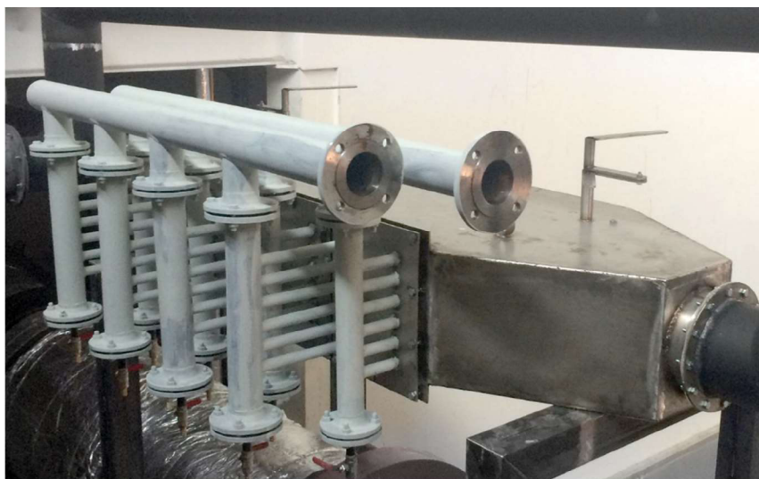
Obr. 11: Výměník po instalaci. Autor fotografie: J. Bojanovský.
