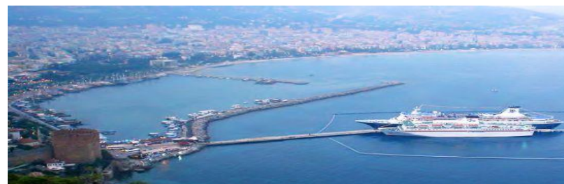
Kotviště výletních lodí v přístavu Alanya
