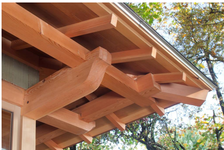
Obr. 12 - Japonská střešní konstrukce
