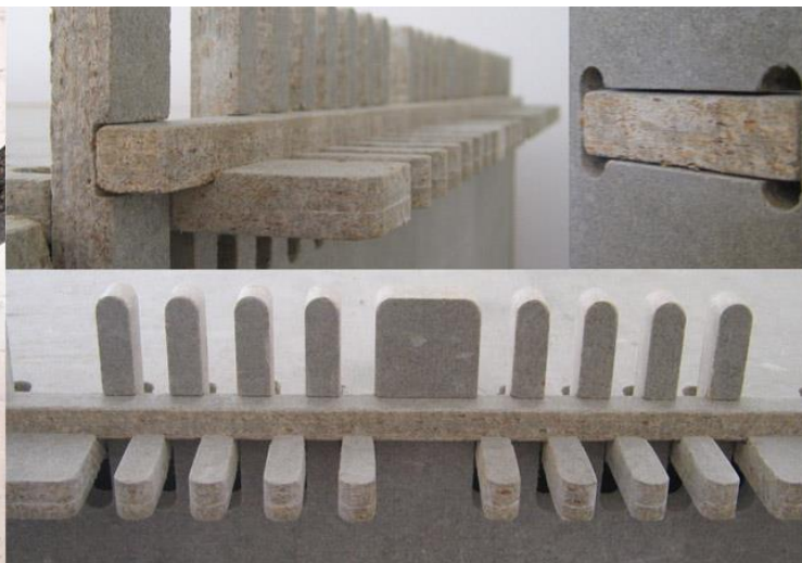
Obr. 49 - Spoj skříně z cemento-vláknité desky
