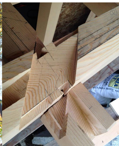
Obr. 13 - Detail spojení krovu
