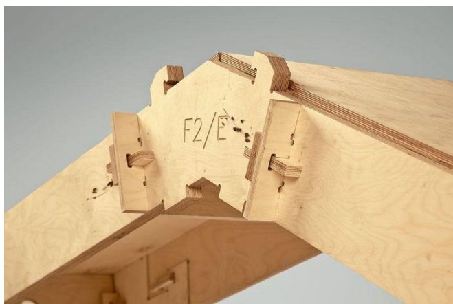
Obr. 44 - Detail konstrukce domu z projektu Wikihouse
