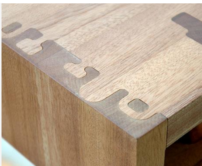
Obr. 90 - Polokrytý ozub v podání CNC spoje
