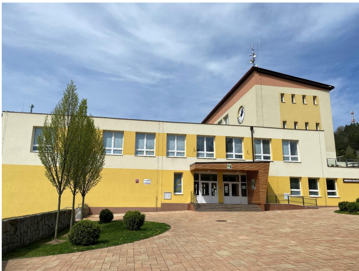
Obr. 8: Základní škola Hutisko-Solanec
