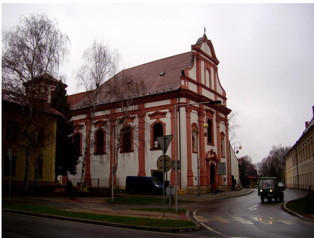
8. Příbor, kostel sv. Valentina, 1760-1766, stav v roce 2016.
