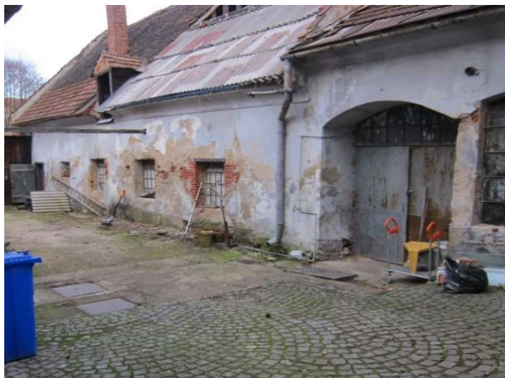
Obrázek 12 - Pohled na hospodářské stavení, kde byla nelegální chemická laboratoř (zdroj: PČR NPC SKPV, 2016)
