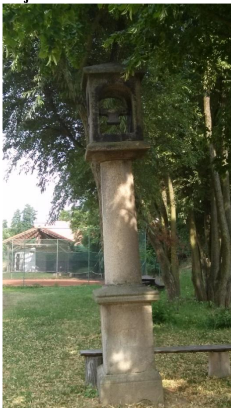
Obrázek 12- Zvonička v Ohrobcí před rekonstrukcí
