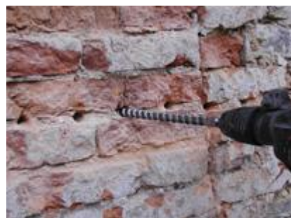
Obr. 3: Vyvrtání a vyčištění otvorů
