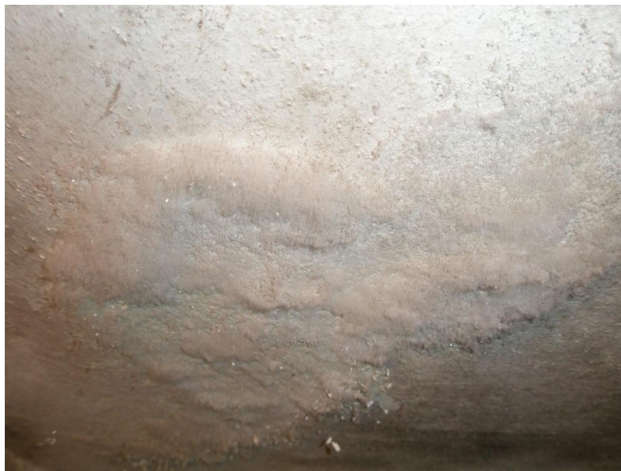
Foto 2: Výskyt plísní na stropu chodby
