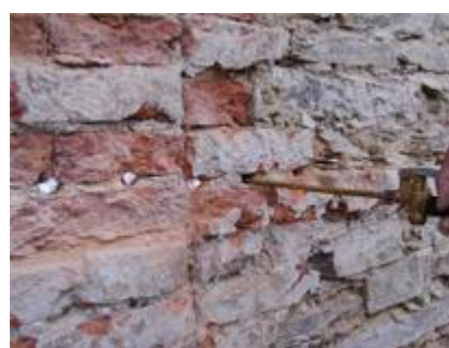
Obr. 5: Působení krému proti zemní vlhkosti
