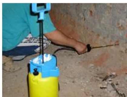
Obr. 4: Naplnění otvorů krémem
