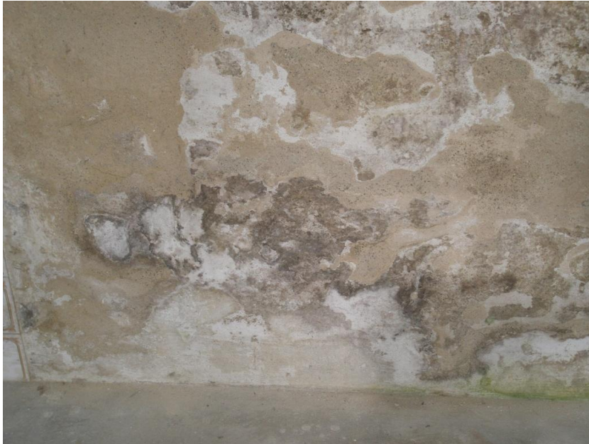
Foto 7: Rozsáhlé vlhkostní mapy (pohled u podlahy, vedle spíže) ve „staré kuchyni“
