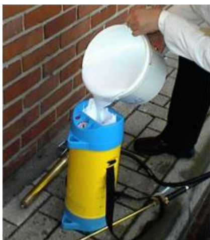
Obr. 2: Naplnění aplikační nádoby krémem
