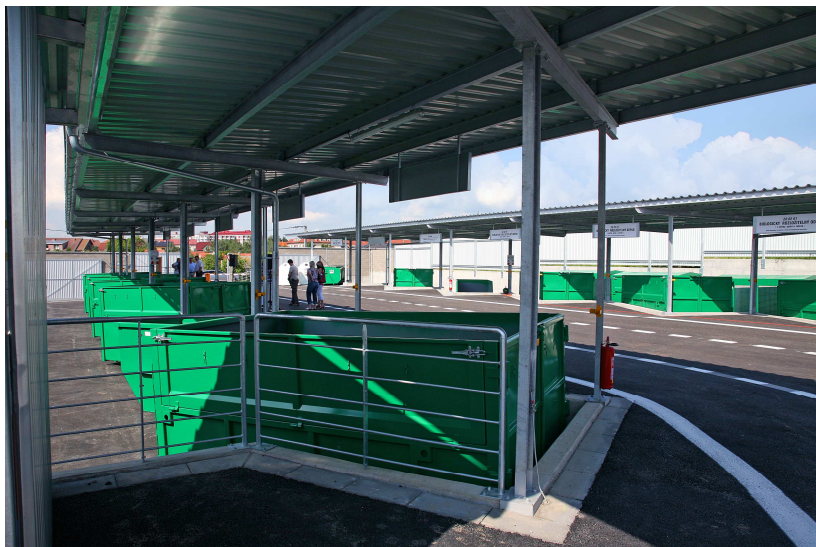
Obrázek č. 10 - Nově vybudovaný sběrný dvůr Na Klinkách - Třebíč
