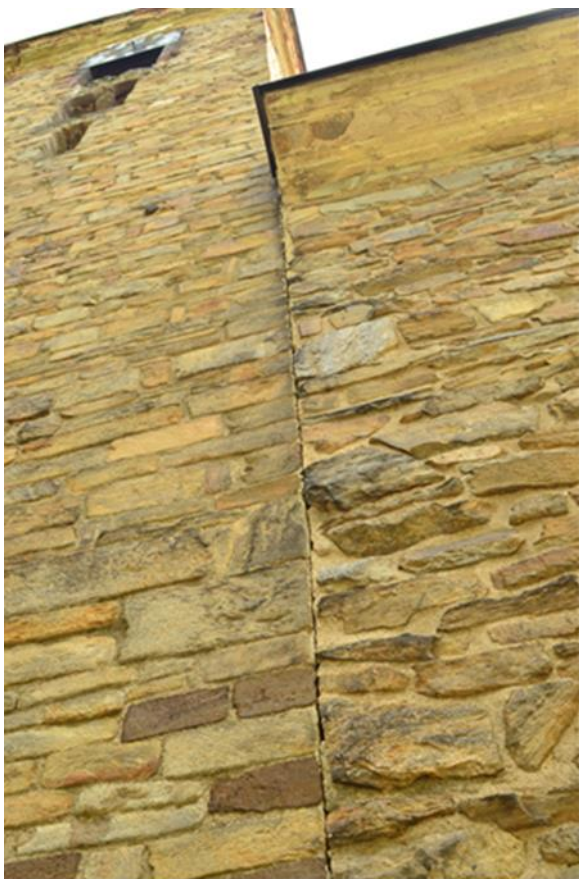
Obr. č. 11. Předěl mezi západní zdi lodi kostela a západní zdí věže. – Foto autor (rok 2021).
