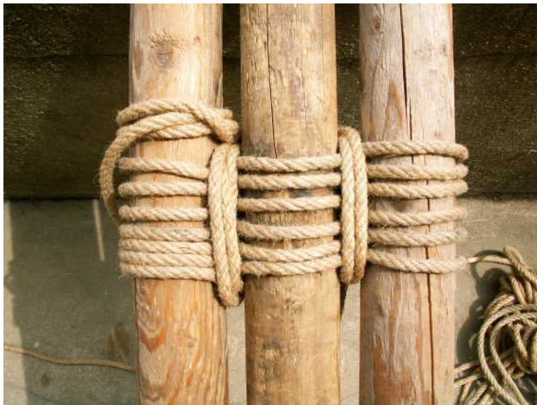
Obr. 5: Vrcholová vazba – detail
