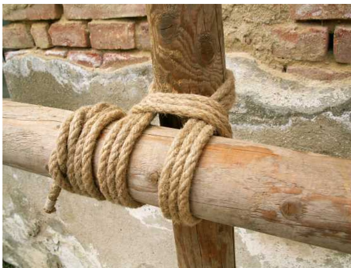
Obr. 4: Kolmá vazba – detail
