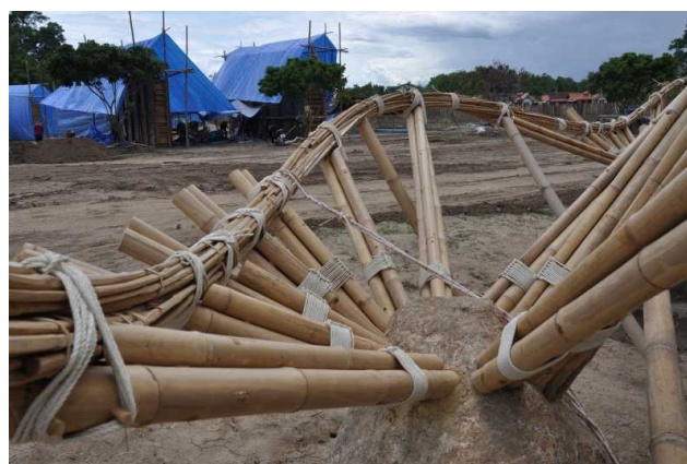
Obr. 27: Panyaden School – detail založení (převzato z [15])
