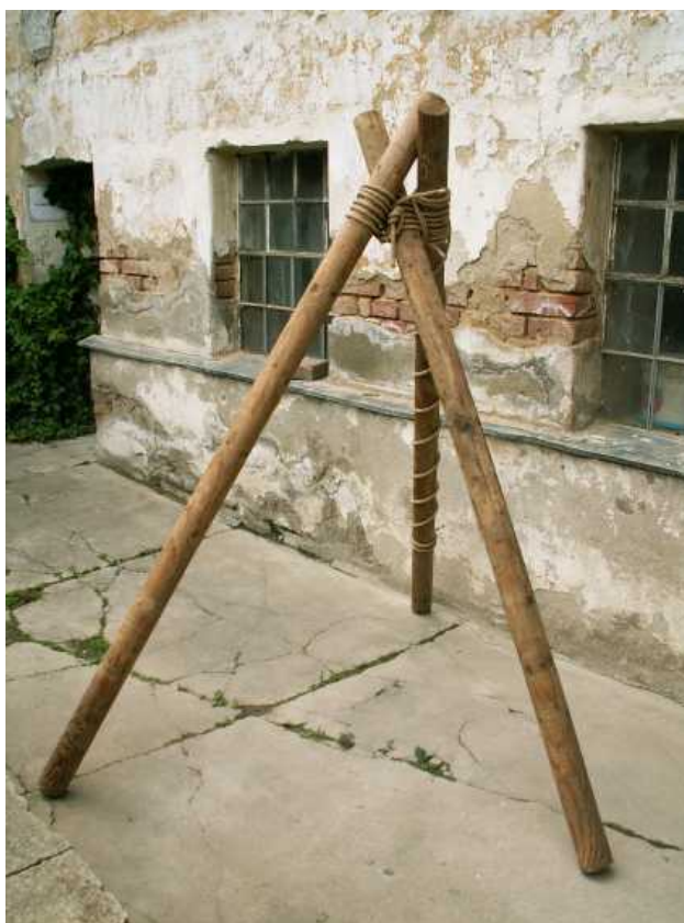
Obr. 6: Trojnožka spojená vrcholovou vazbou
