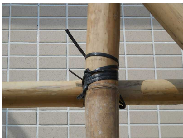
Obr. 29: Spoj bambusového lešení (převzato z [6])
