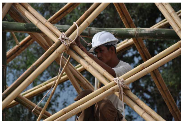
Obr. 26: Panyaden School – detail spojů (převzato z [15])
