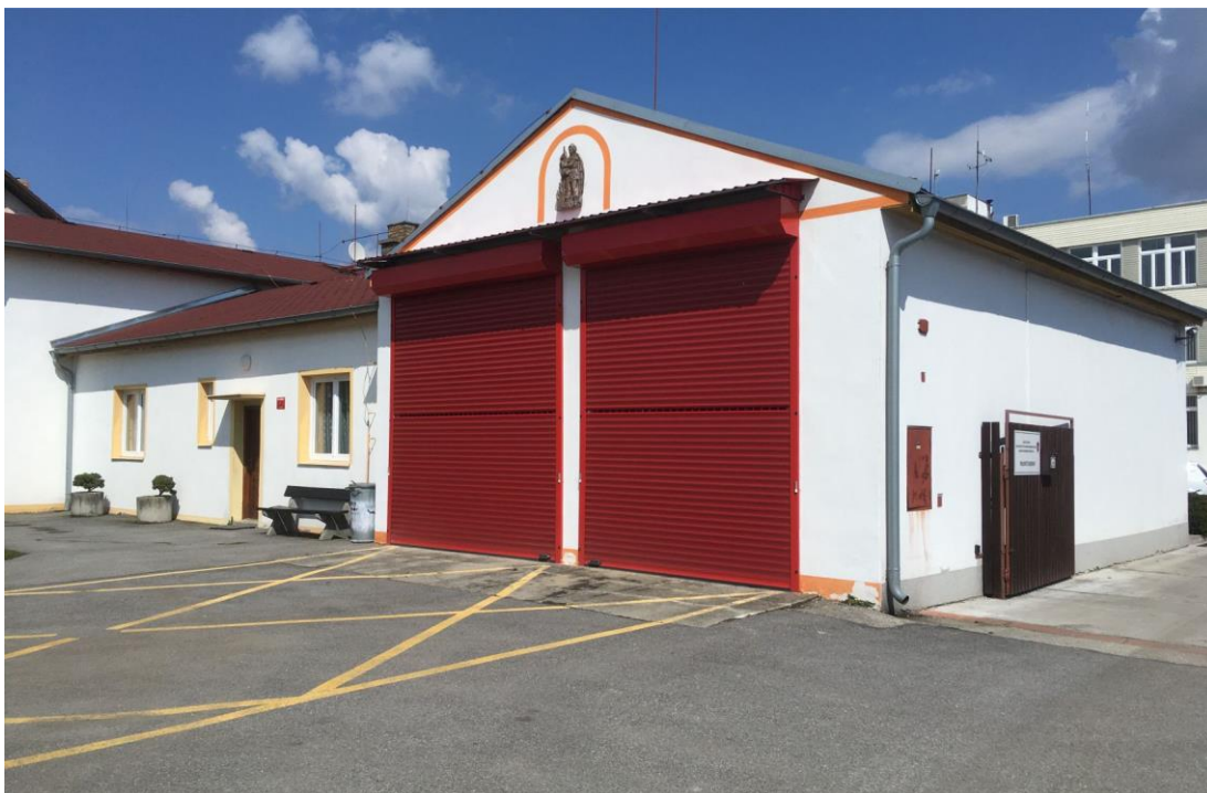
foto č. 1 – celkový pohled z jihozápadu
