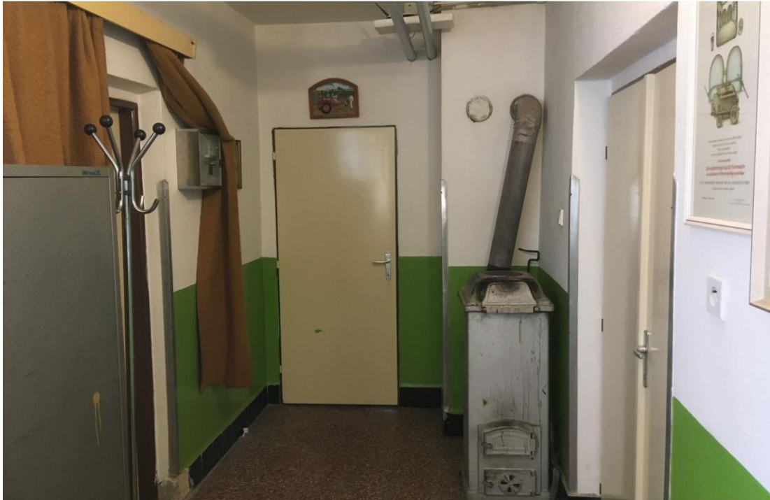
foto č. 9 – řešená část propojovací chodby
