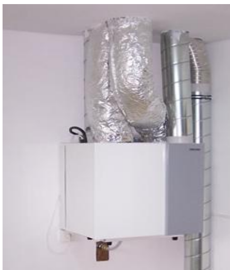
Foto. č. 6.: Rodinný dům v Teplicích; Tepelné čerpadlo vzduch/voda (vnitřní varianta), řešení umístění TČ.
