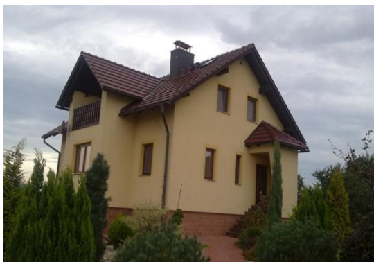
Foto. č. 3.: Rodinný dům Studénka; Tepelné čerpadlo země/voda
