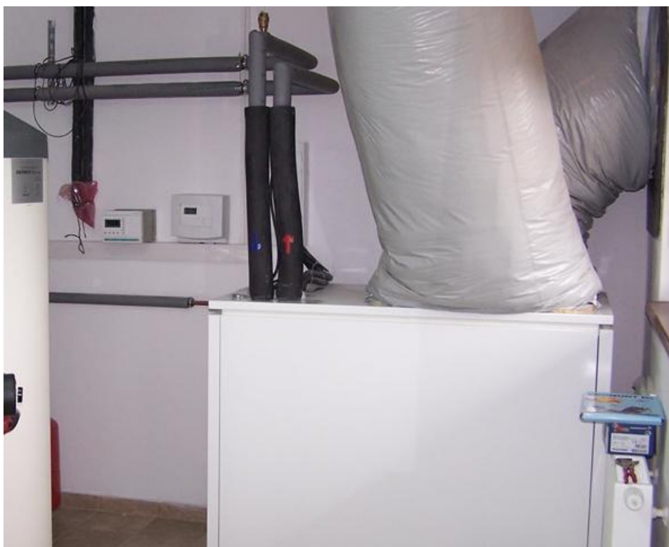
Foto. č. 6.: Rodinný dům v Teplicích; Tepelné čerpadlo vzduch/voda (vnitřní varianta), řešení umístění TČ.
