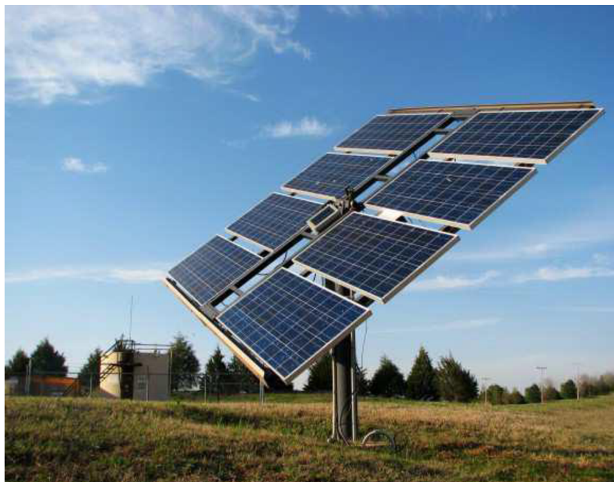
Obrázek 3 Fotovoltaický panel na trackeru
