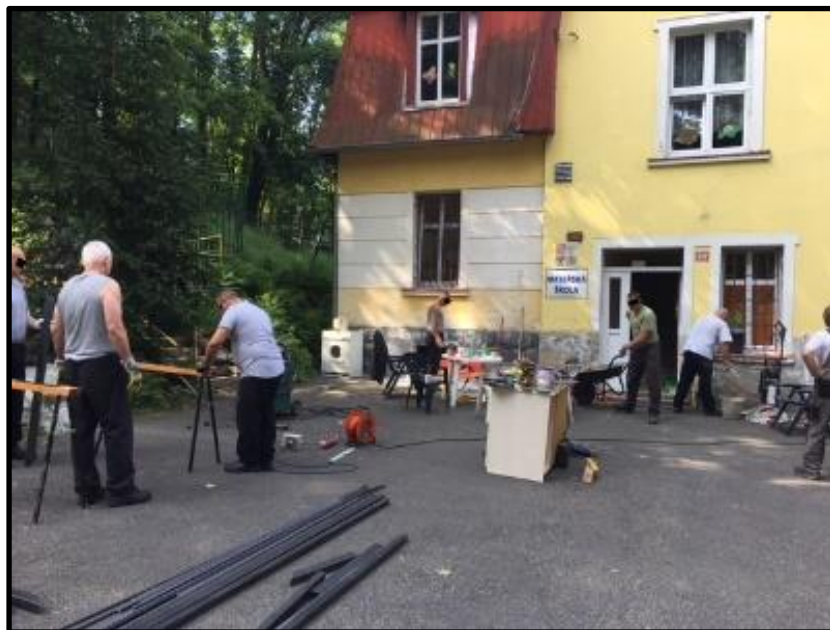
pomocné práce odsouzených při rekonstrukci mateřské školy v Nejdku
