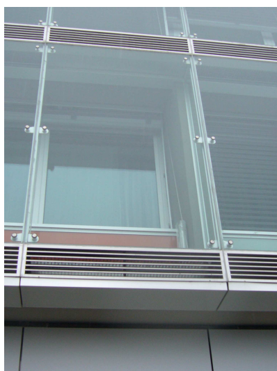
Obr. 14 Nerezový terč pro uchycení jednoduchého bezpečnostního prosklení.
