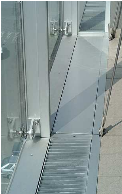
Obr. 15 Přívod vzduchu v dolní části meziprostoru [9].
