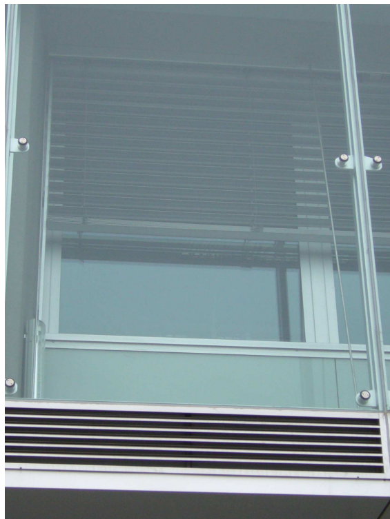
Obr. 13 Chodbový meziprostor, hliníkové mřížky a žaluzie.
