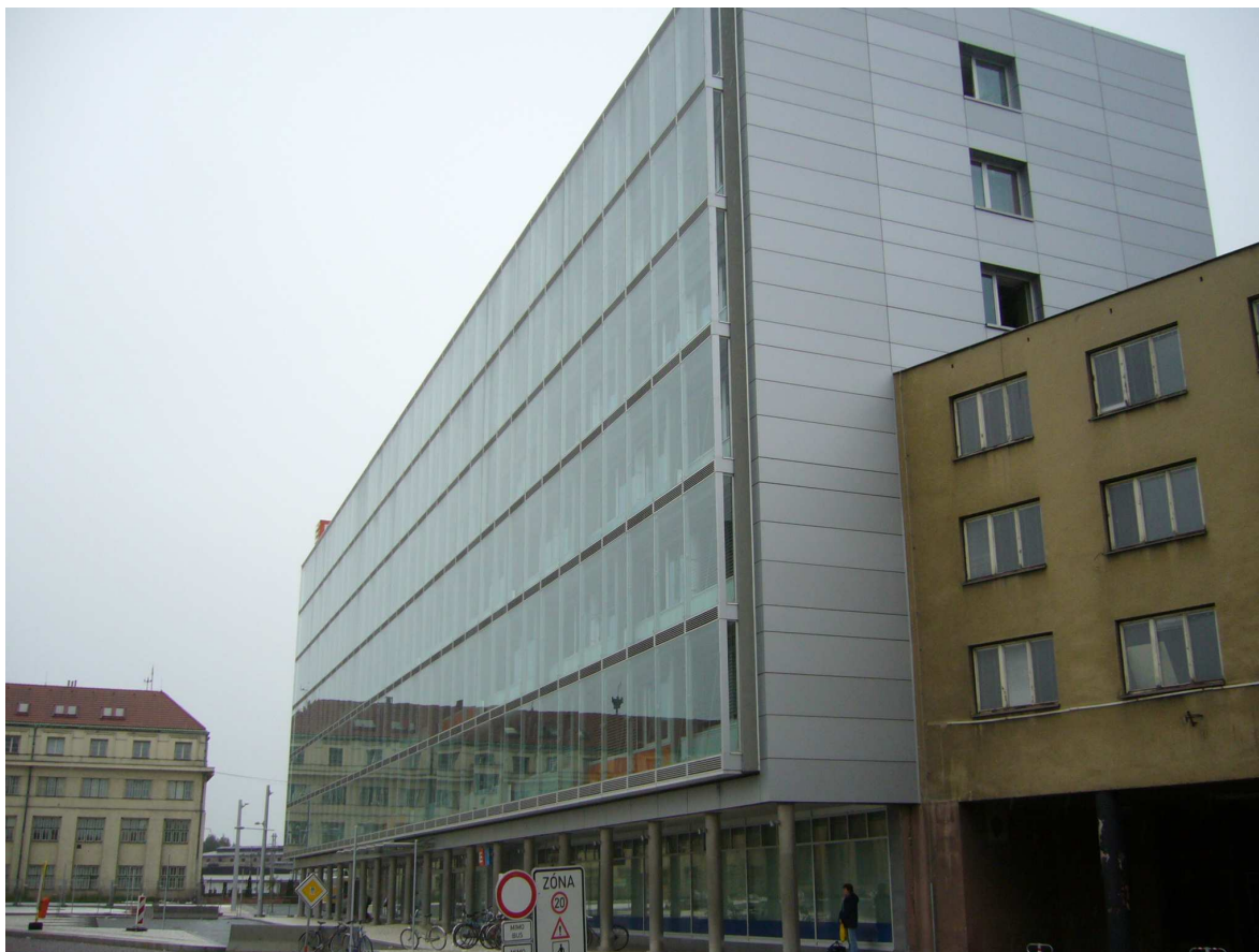
Obr. 11 Dvojitá transparentní fasáda na budově ČEZ,a.s. v Hradci Králové.
