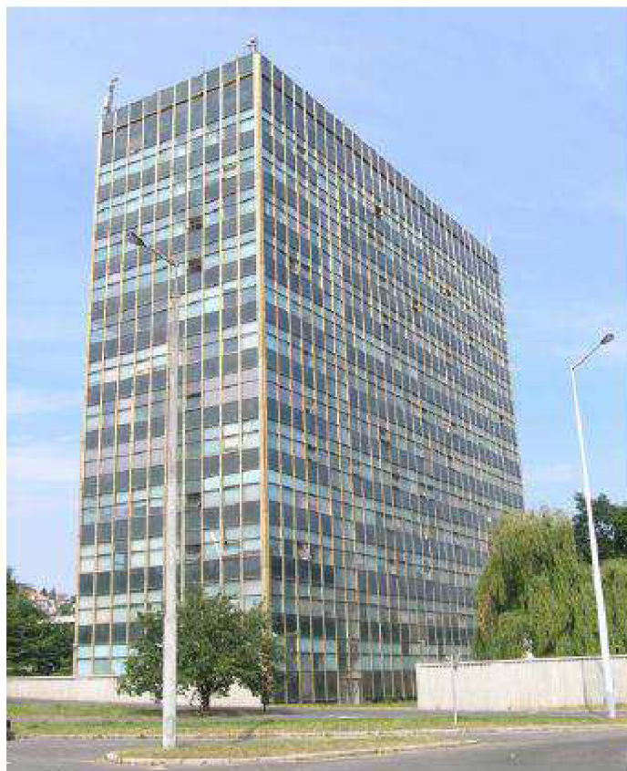
Obr. 20 Pohled na jihozápadní část objektu MFF Univerzity Karlovy [13].
