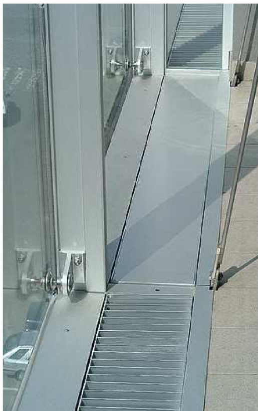
Obr. 15 Přívod vzduchu v dolní části meziprostoru [9].
