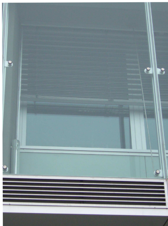
Obr. 13 Chodbový meziprostor, hliníkové mřížky a žaluzie.
