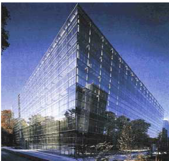
Obr. 5 Victoria-Ensemble, Köln, Německo Budova tvaru obráceného kosého jehlanu (6 NP) Dvojitá transparentní fasáda s průchodným – chodbovým meziprostorem s uzavíratelným okruhem. Výška sekce je totožná s výškou budovy. Aerodynamika je založena na přirozeném proudění vzduchu. Vnější transparentní stěna je s jednoduchým bezpečnostním zasklením. Vnitřní transparentní stěna je dvojnásobný tepelně izolační systém. Protisluneční ochrana je ve vnitřní zóně meziprostoru [1].
