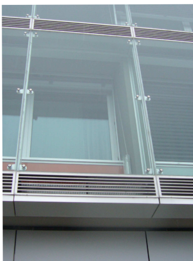
Obr. 14 Nerezový terčík pro uchycení jednoduchého bezpečnostního prosklení.
