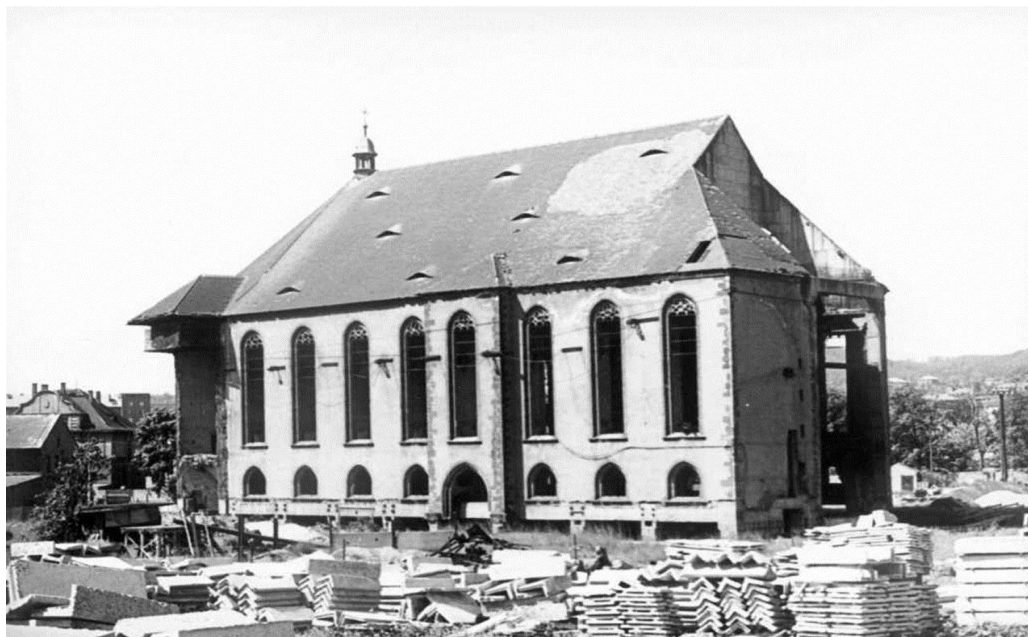
Obr. č. 5 - Přesouvání kostel Nanebevzetí Panny Marie
