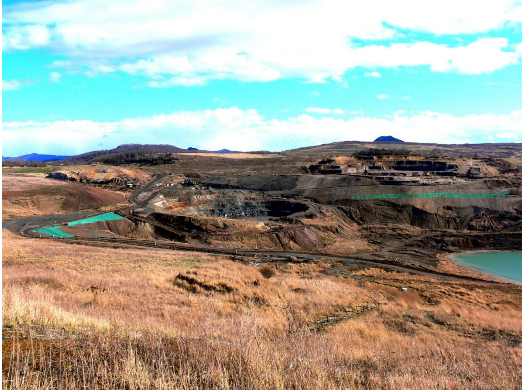
Obr. č. 6 - Pohled na část zpevnění břehové linie jezera Most
