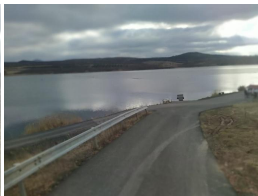
Obrázek 14 - Příjezd ke stanovišti č. 2
