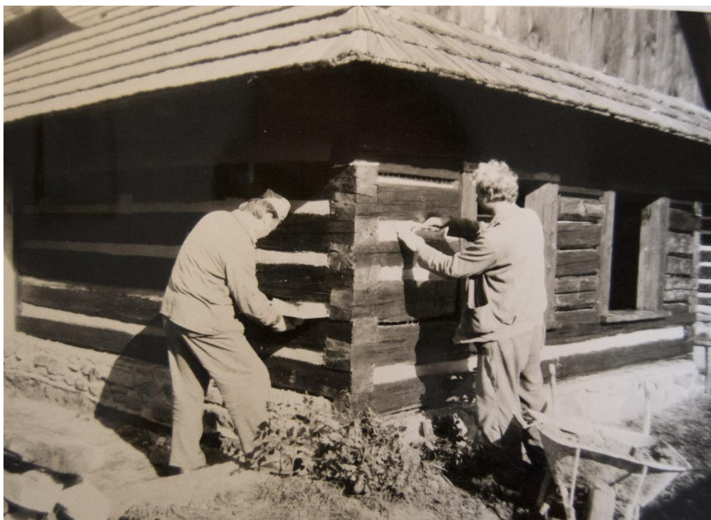
63. Hlinsko, Betlém, spárování objektu čp. 62.
