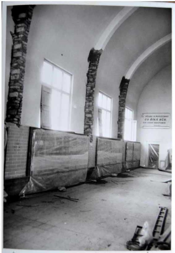
120. Hlinsko, Husův sbor, vyzdění degradovaných dřevěných vazníků.
