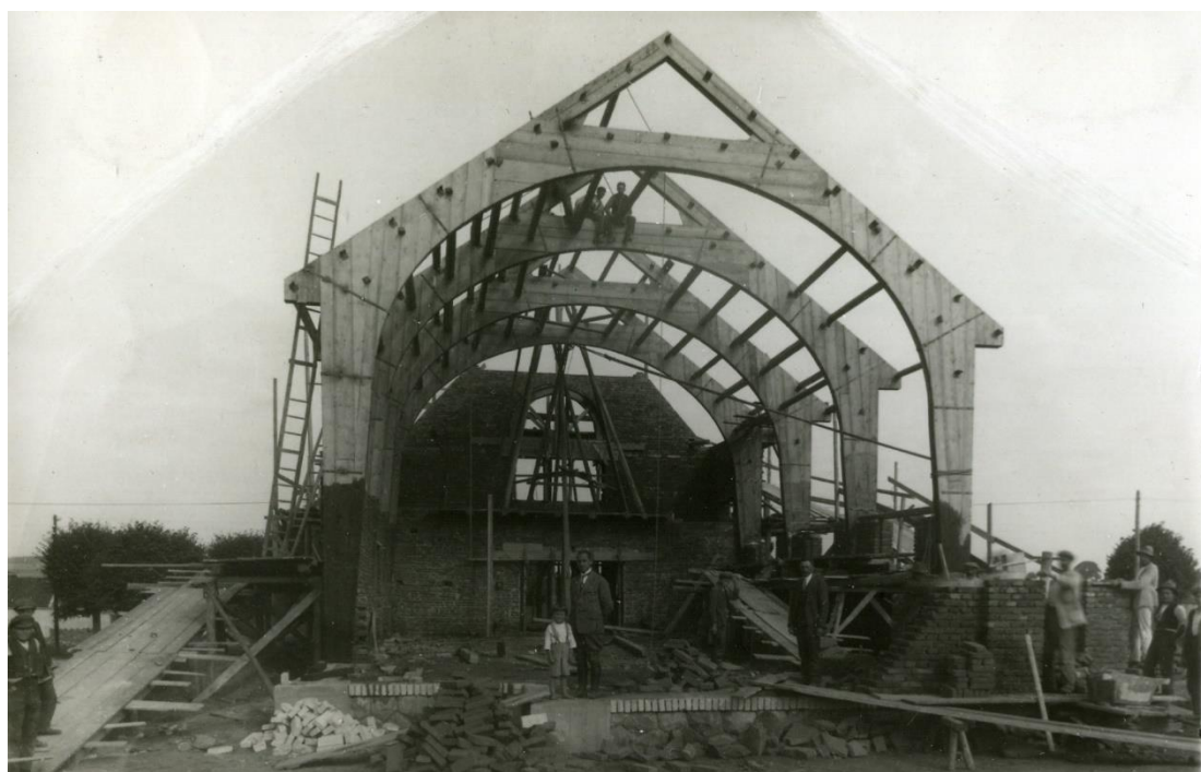
118. Hlinsko, Husův sbor, tzv. dřevěné vazníky tvořící rám konstrukce, 1925.
