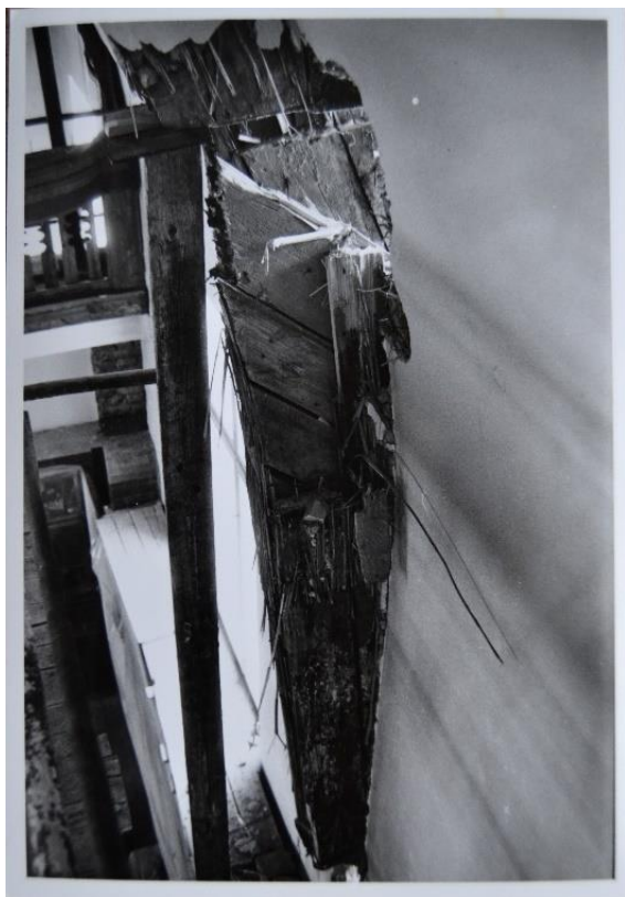
120. Hlinsko, Husův sbor, vyzdění degradovaných dřevěných vazníků.
