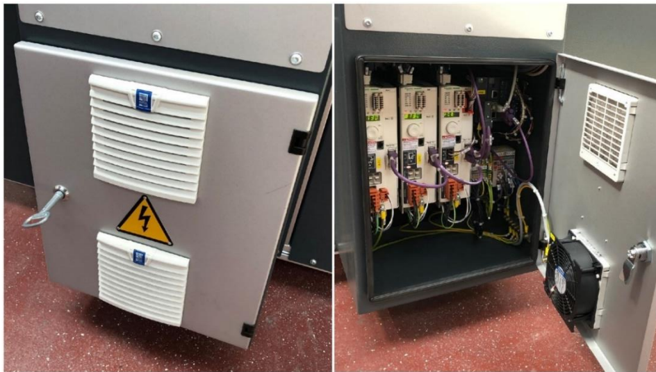
Obr. 23: Znárodnění činnosti kontrola konektorů a rozvodů v elektrorozvaděči automatického výměníku palet pomocí obrázků
