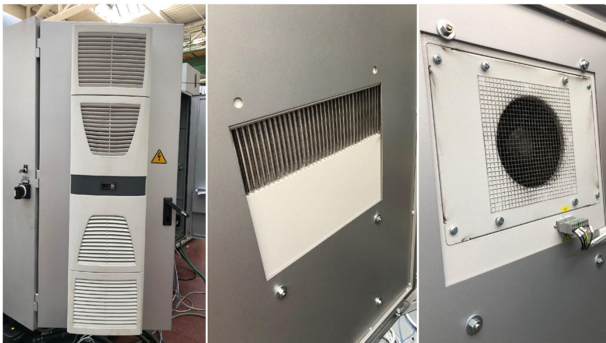
Obr. 27: Znárodnění činnosti čištění štěrbin chladiče elektroskříně pomocí obrázků
