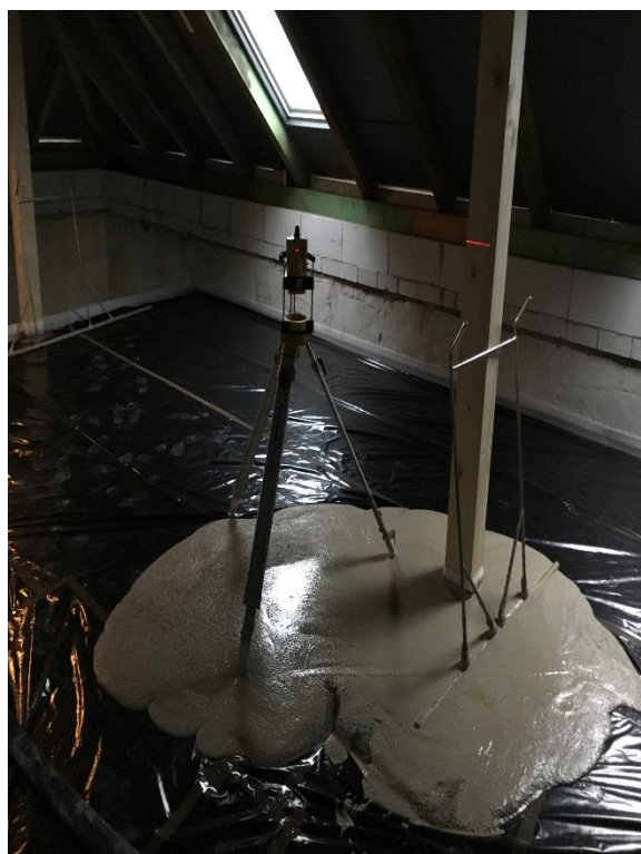
Obr 2: Fotografie laserového rotačního přístroje - foto autor
