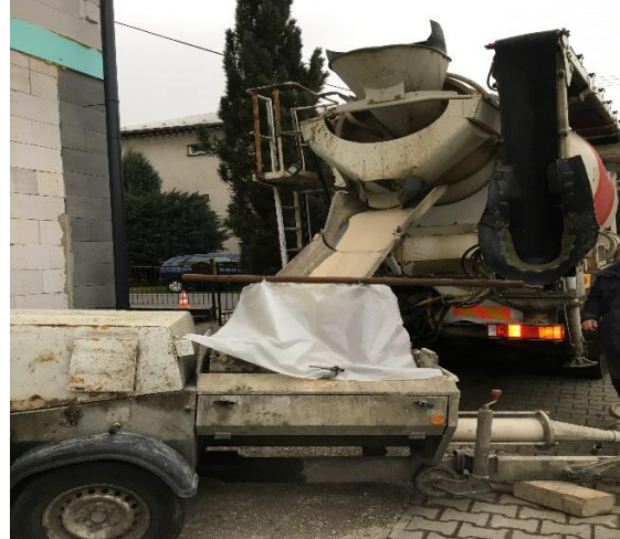
Obr. 8: Zobrazení šnekového čerpadla na stavbě – foto autor
