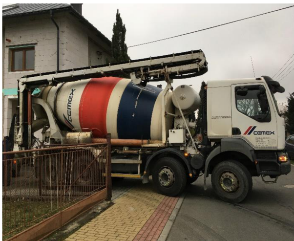
Obr. 7: Fotografie automixu na stavbě – foto autor
