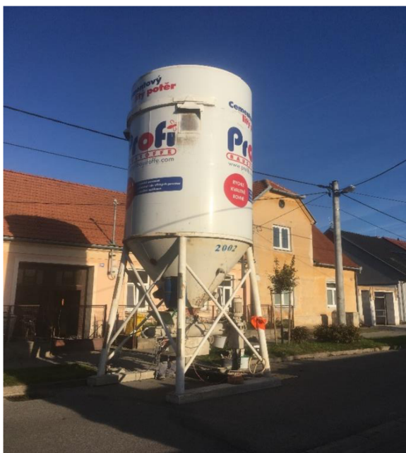
Obr 3: Umístění sila se suchým potěrem na stavbě – foto autor
