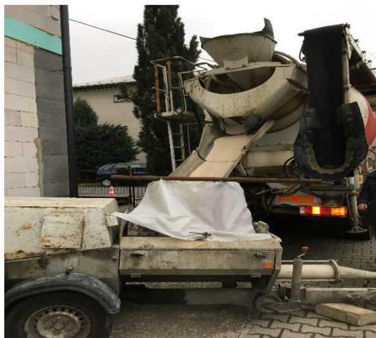
Obr. 8: Zobrazení šnekového čerpadla na stavbě – foto autor
