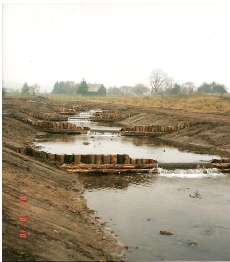
Obr. 9 Koryto po úpravě. (Lesy ČR)
