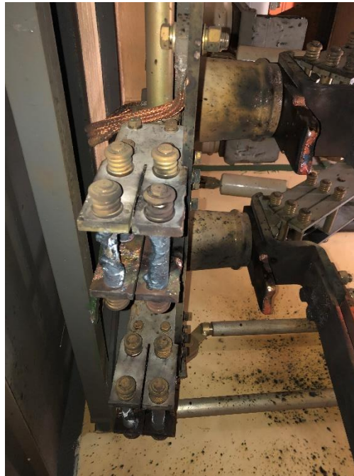
Obr. 1.2 Nože uzemňovača po skrate
