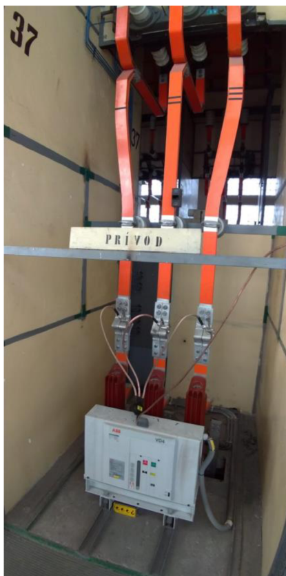
Obr. 1.4 Otvorené prevedenie rozvádzača
