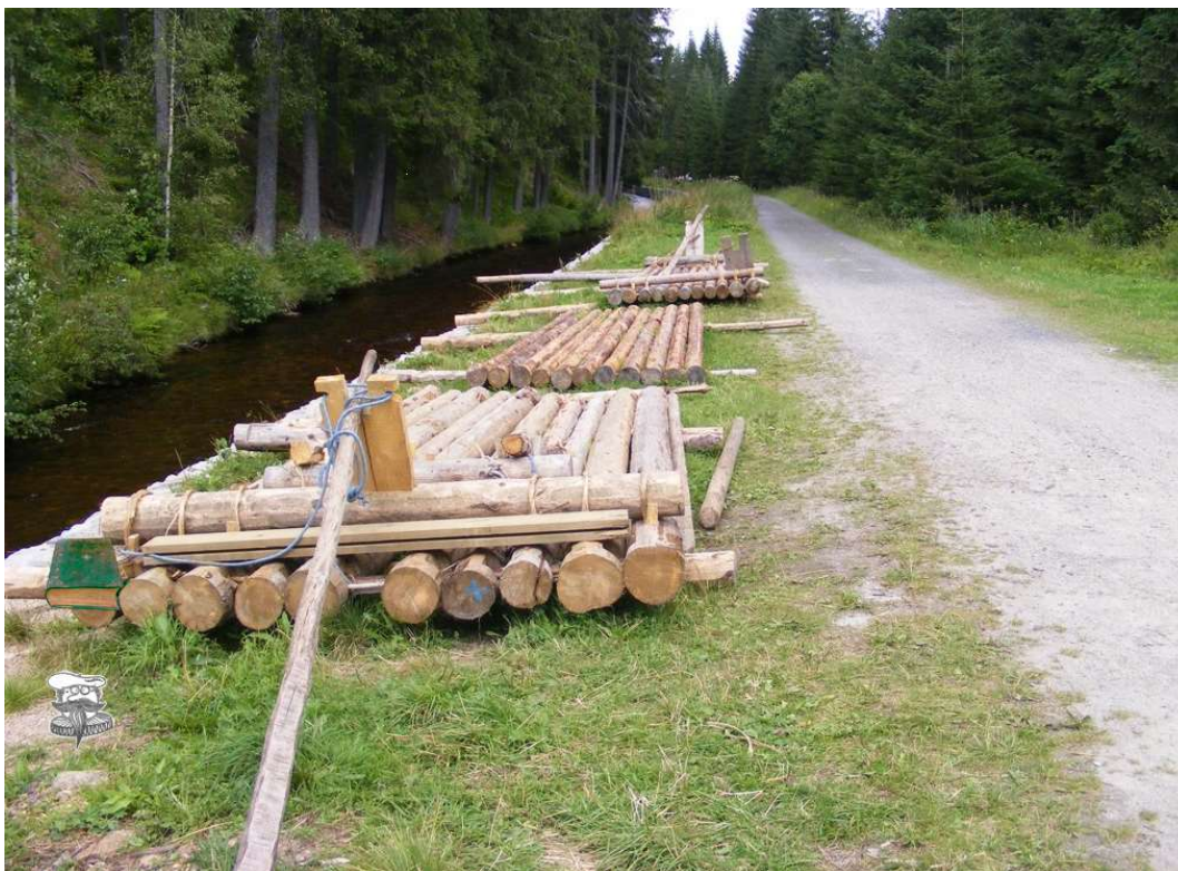
Obr. 21: Scéna 6 – Vchynicko-tetovský plavební kanál
