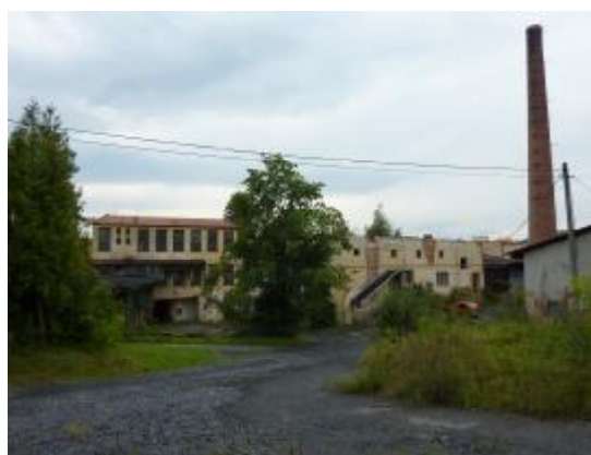
Foto 7: Klatovská továrna bratří Wienerů
