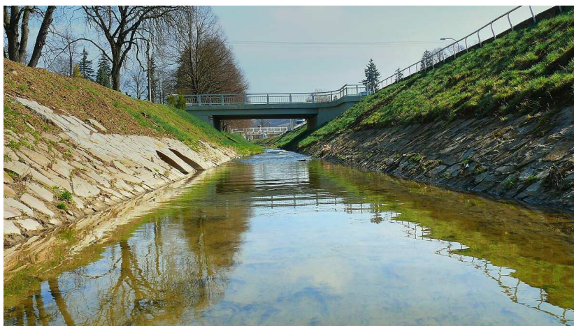
Obr. 6. Střední část úseku č. 1.
