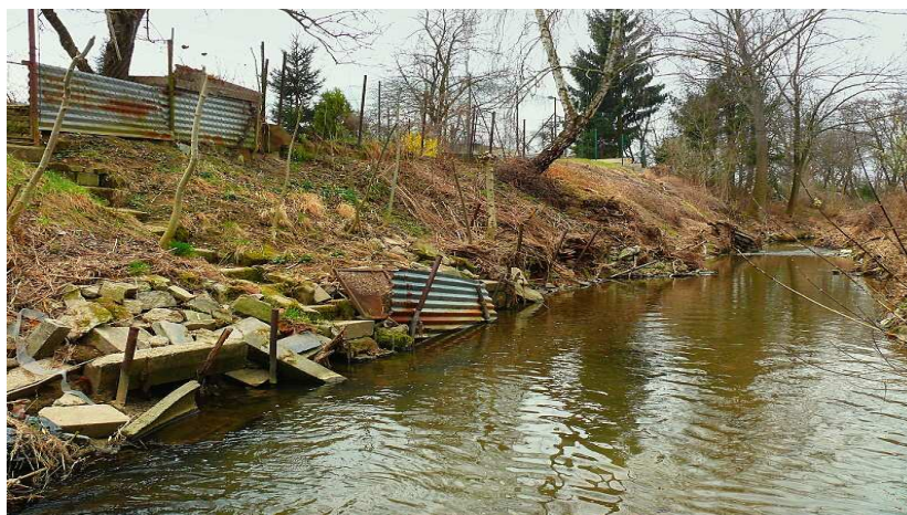
Obr. 10. V horní části úseku č. 3 si lidé opevňují pod svými zahradami patu svahu a část břehu již tak upraveného toku Březnice
