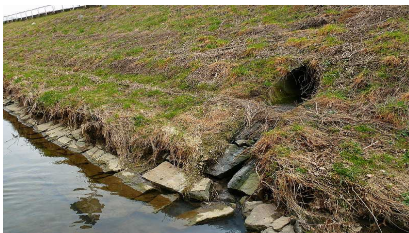
Obr. 8. Opevnění paty svahu a vyústění kanalizace na úseku č. 2.
