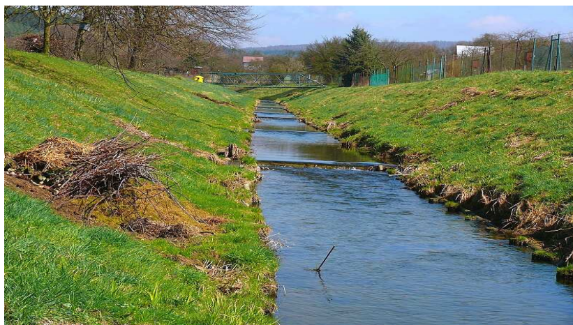
Obr. 4. Dolní část úseku č. 1, nad druhým Březolupským stupněm
